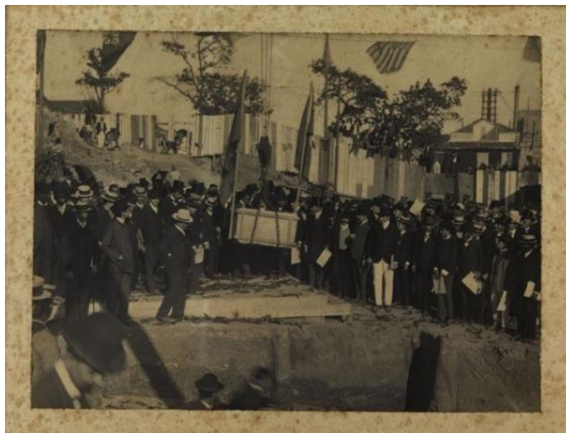
Figura 18: Lançamento da pedra fundamental no edifício destinado à Biblioteca Nacional.
