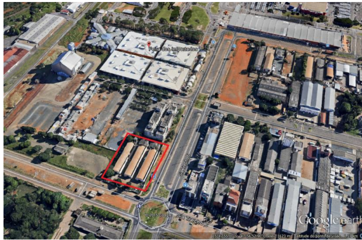
Figura 3.2 – Obra A: Trecho 5, Lotes 10 a 60 - Brasília-DF
