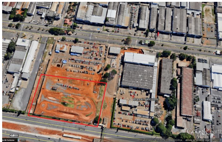
Figura 3.3 – Obra B: Trecho 1, Lote 780 - Brasília-DF
