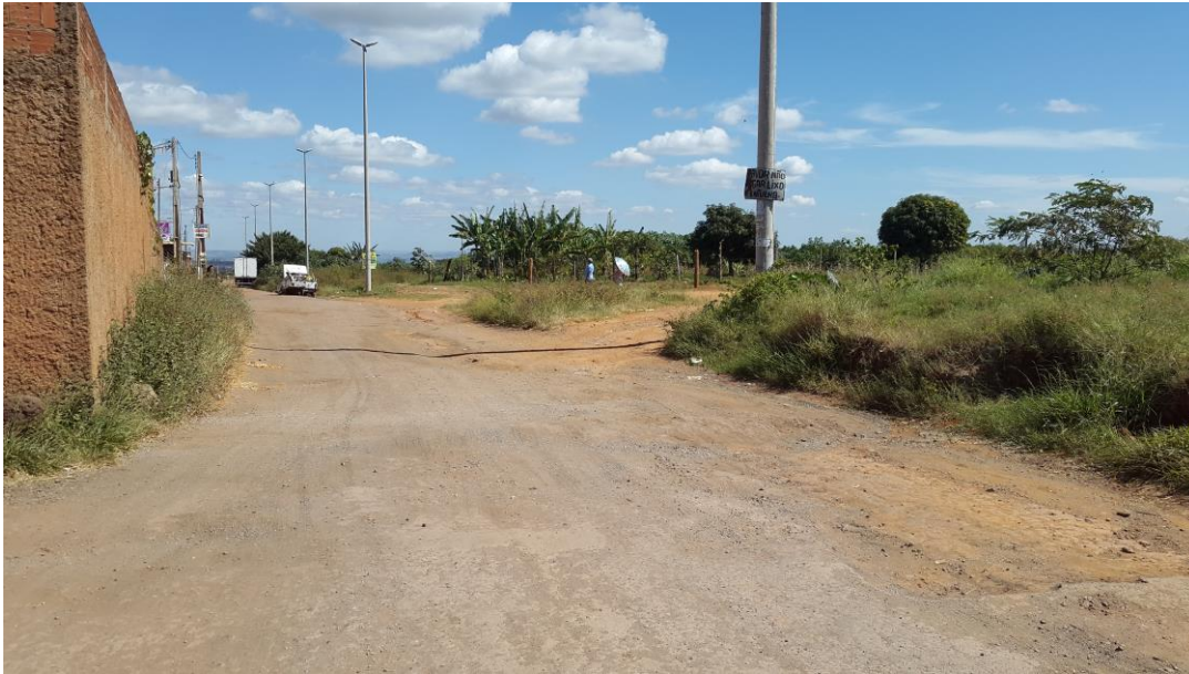
Figura 25: Falta de infraestrutura
