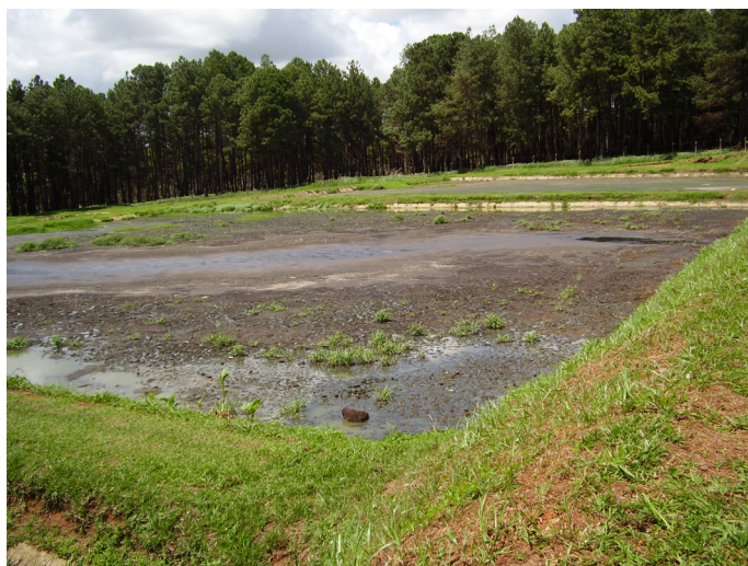
Figura 4.4 - Leito de secagem do lodo anaeróbio.
