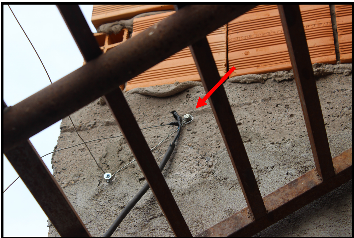
Figura 4-2 – Destaque para o ponto de fixação, por meio de parafuso metálico, do cabo flexível ao segmento de arame.
