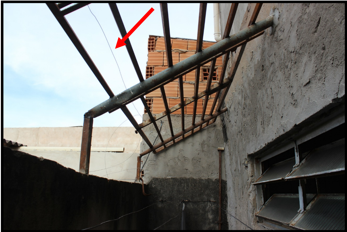
Figura 4-1 – Gradil metálico de proteção dos fundos do lote com destaque para o arame liso.
