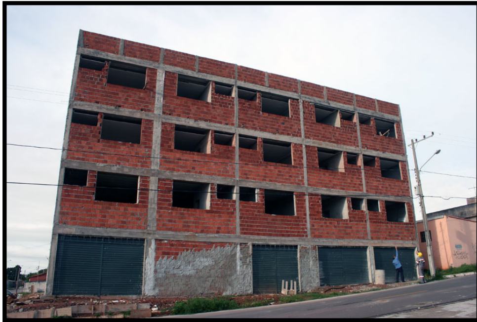
Figura 4-7 – Fachada do edifício examinado paralela à rede primária de distribuição.
