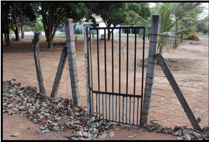
Figura 4-10 – Porteira metálica que funcionava como uma chave do circuito criado pela cerca energizada, interrompendo-o quando se encontrava aberta.
