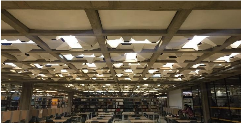
Figura 32 - Pirâmides truncadas no forro da biblioteca
