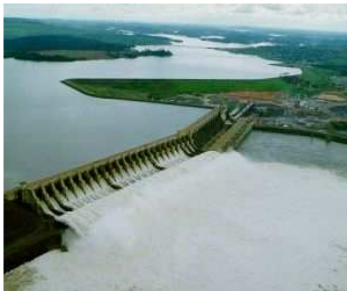
Figura 4.33 – Imagem de uma parte em concreto da barragem de Tucuruí/Pará/Brasil - ELETRONORTE. Fonte: site da Camargo Correa.
