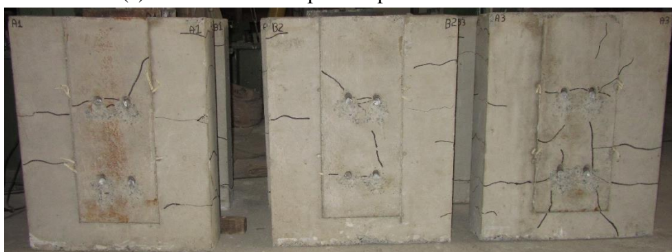
(b) Lajes após destacamento.
