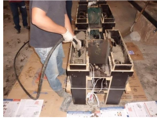
(b) Adensamento do concreto.
