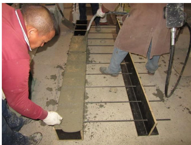
(b) Concretagem dos corpos de prova prismáticos.
