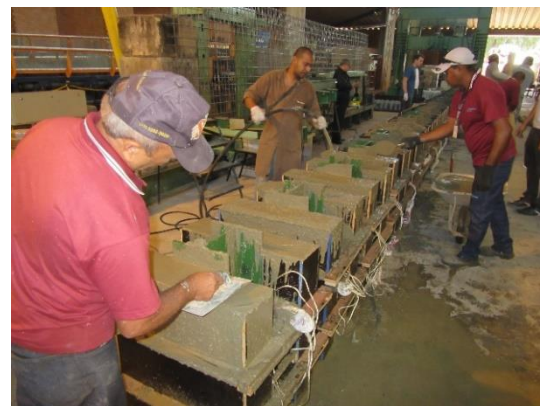
(b) Adensamento do concreto.
