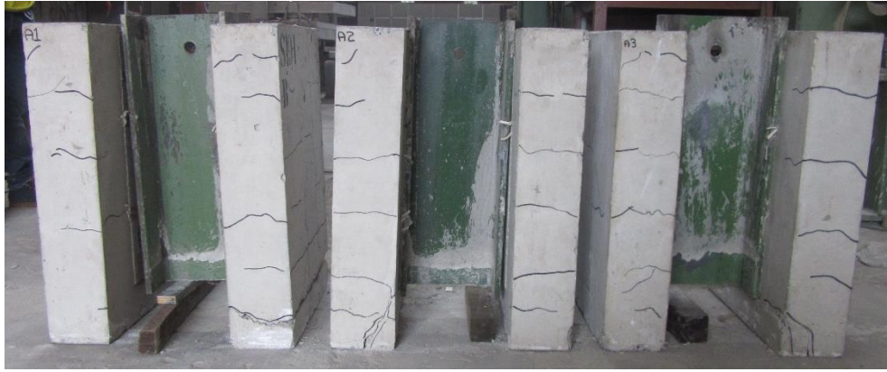
(a) Lateral das lajes A e B.
