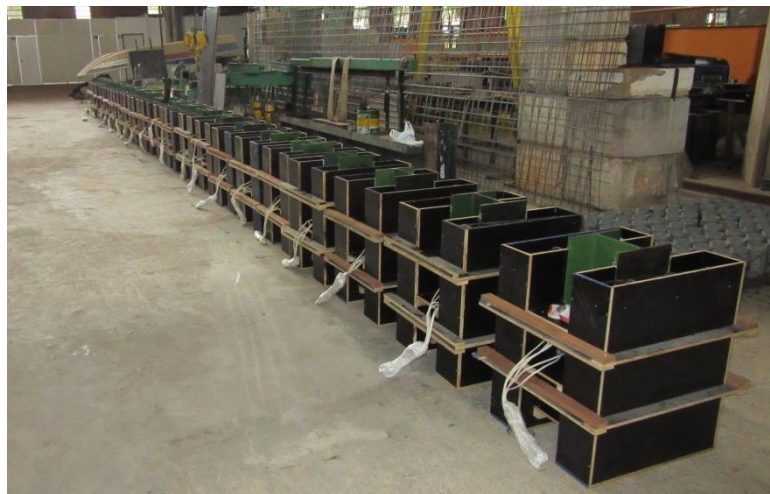
(c) Formas com os modelos posicionados para a segunda concretagem.
