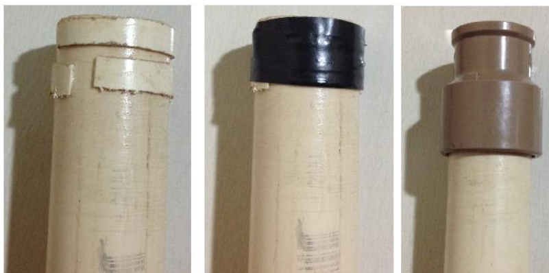
Figura 38: montagem d final do tubo de 40.
