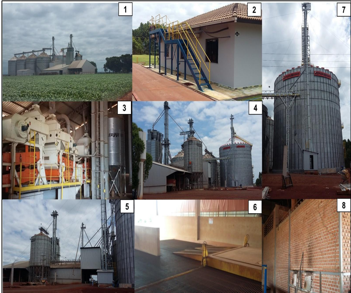
Figura 17– Estrutura Física do Condomínio de Armazém Rural (B).
