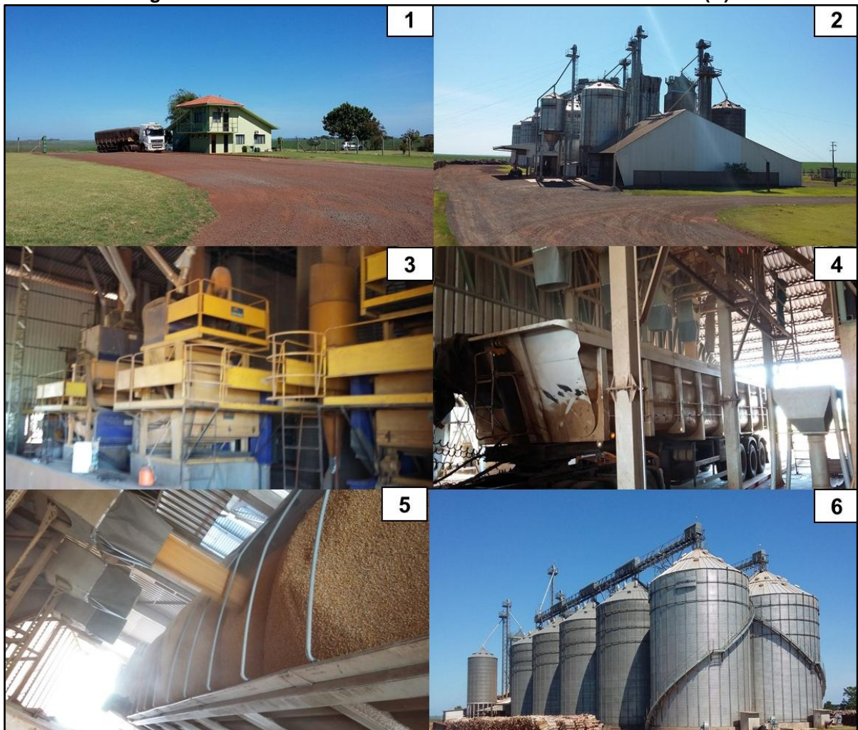
Figura 18 – Estrutura Física do Condomínio de Armazém Rural (C).
