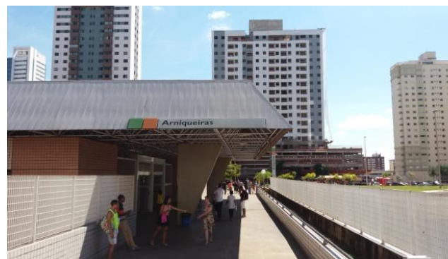
Figura 82: Acesso na imediação da Estação Águas Claras.
