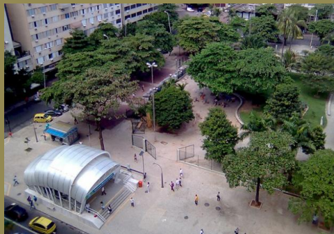
1) Acesso - trecho subterrâneo – RJ
