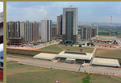
4) Trecho em trincheira – DF
