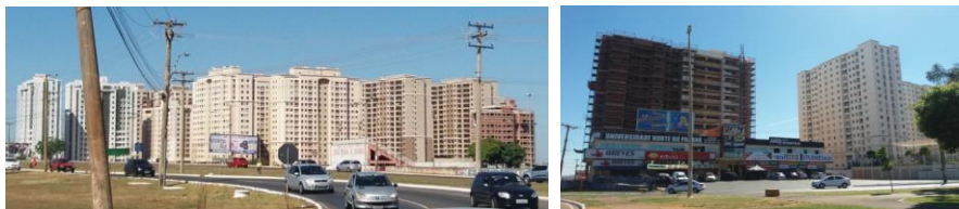
Figura 93: Vista da Área de Influência Mediata da Estação Samambaia.
