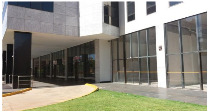
Figura 85: Vista a partir da All da estação Arniqueiras.
