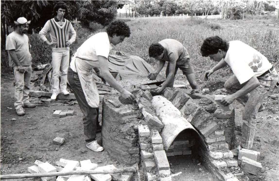
Figura 32: Início Oficina do Barro, s/d. Construção do primeiro forno cerâmico a lenha. Fonte: Acervo MVMC
