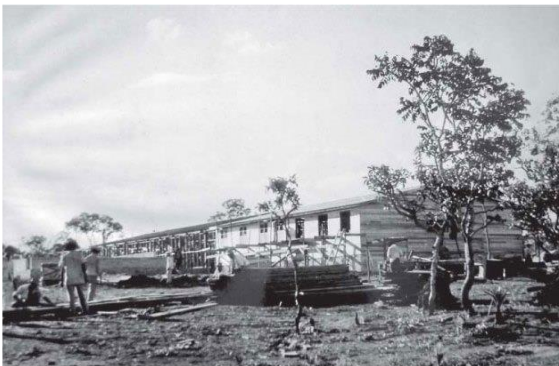
Figura 3: Hospital Juscelino Kubitschek de Oliveira - HJKO, em construção, 1957. Fonte: Foto arquivo pessoal Dr. Edson Porto, primeiro diretor do hospital.
