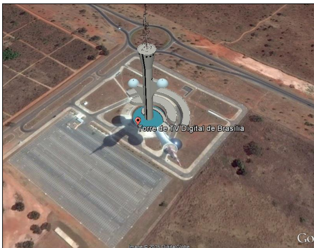
Figura 32 - Localização via satélite da Torre de TV Digital de Brasília, coordenadas geográficas: 15° 41' 31" S e 47° 51' 13" W - Disponível em: < Google Earth >. Acesso em: 02/04/2016
