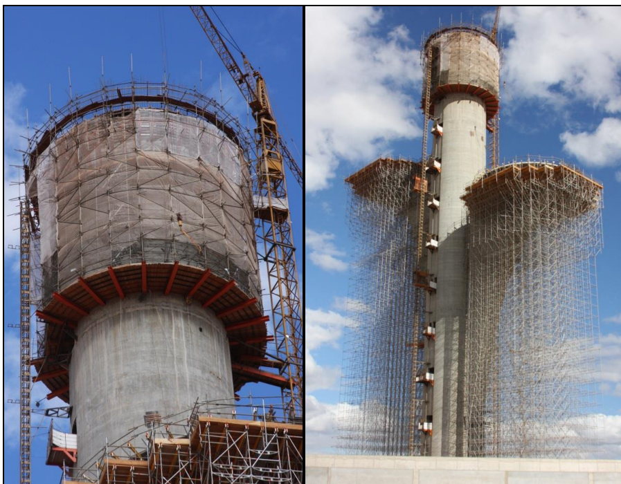
Figura 39 - Detalhe da construção do cálice da Torre de TV Digital de Brasília - (ArPDF)
