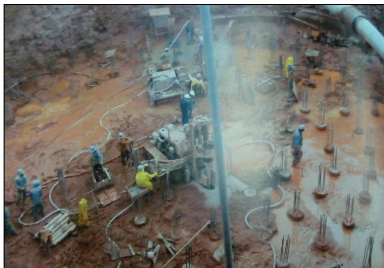
Figura 37 – Execução das estacas - Gorgulho (2012)
