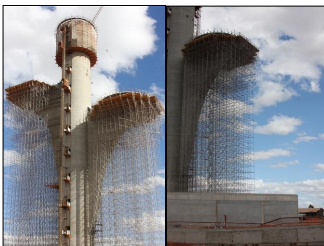
Figura 40 - Execução dos braços externos da Torre de TV Digital de Brasília - (ArPDF)
