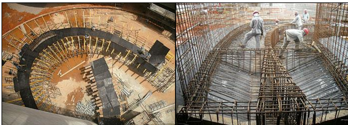
Figura 43 - Execução das rampas de acesso a Torre -
