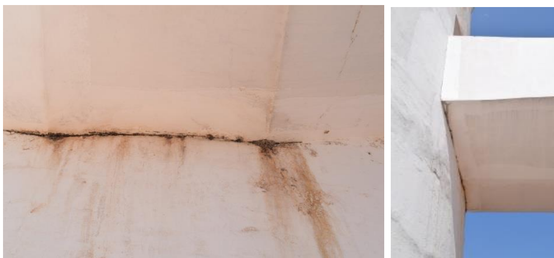
Fuste (pilar parede) - Local: Ligação Rampa Entrada e Fuste
