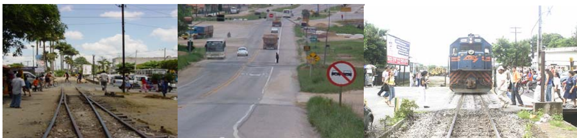
Figura 3.14 – Passagens em nível críticas, em: Macaé (RJ), Rodovia dos Minérios (PR) e Betim (MG), respectivamente.
