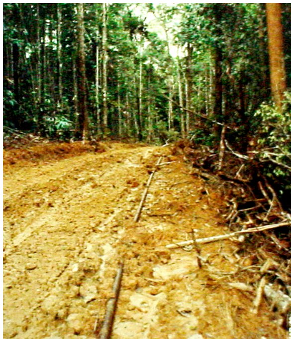
Figura 5.29 – Trecho de estrada aberta para passagem do oleoduto Coari-Tefé. Fonte: Tecnosolo (1989).
