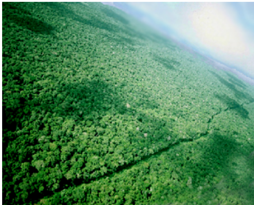
Figura 5.31 – Fotografia de um trecho do poliduto Urucu – Coari. Fonte: Trabalho de campo: Fevereiro de 2003.
