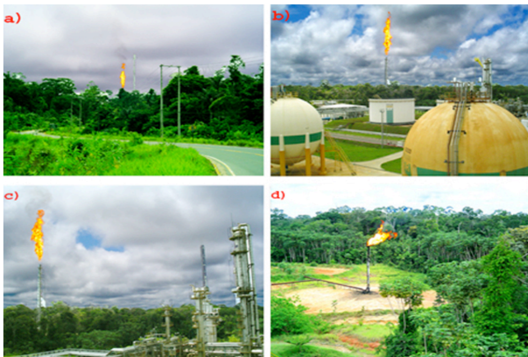
Figura 5.23 – Pólo Araras na PPU: a) trecho da estrada que liga a base de apoio ao pólo Araras; b) vista elevada do pólo Araras e esferas de GLP; c) vista de unidade de GPN; d) primeiro queimador de gás natural.
