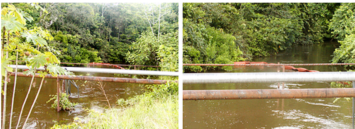
Figura 5.25 – Barreiras de contenção de petróleo no igarapé da Lontra – PPU. Fonte: Trabalho de campo: Abril de 2005.
