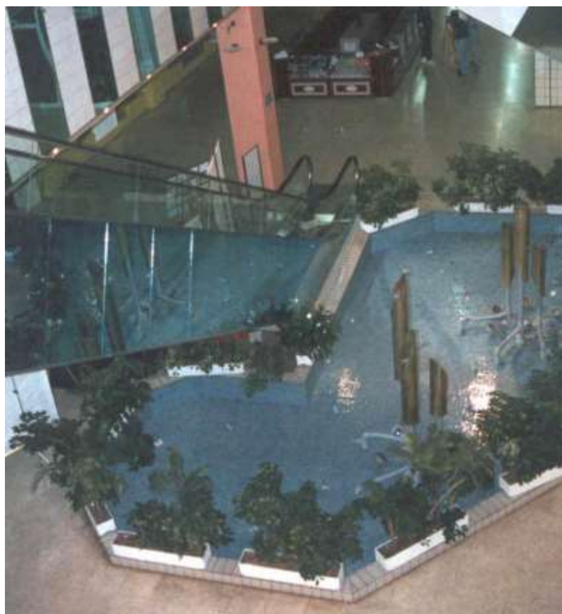
Figura 2.19. Vista do espelho d'água, próximo ao pilar P 137 (Ferreira et al. , 2015).
