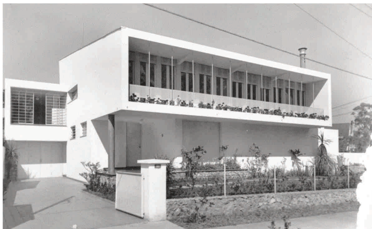
Figura 5 - Casa Benedito Levi, projetada por Vilanova Artigas em 1944, São Paulo – SP. Este projeto exemplifica o a “pouca intimidade” (RUBINO, 2009, p. 69) presente na obra de Artigas: aberturas em toda extensão frontal do volume superior exploram fortemente a relação dentro/fora. Fonte: vilanovaartigas.com
