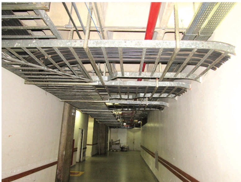
Figura 75 – Vista interna, mostrando as calhas elétricas e rede de chuveiros automáticos. Fonte: Foto do autor.
