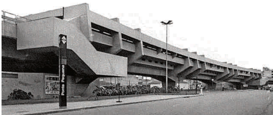
Figura 8 – Obra da empresa Promon Engenharia, a estação Armênia, linha Norte-Sul do Metrô de São Paulo foi projetado pelo arquiteto Marcelo Fragelli enquanto funcionário da empresa, em 1970. Fonte: estacaoarmenia.com.br
