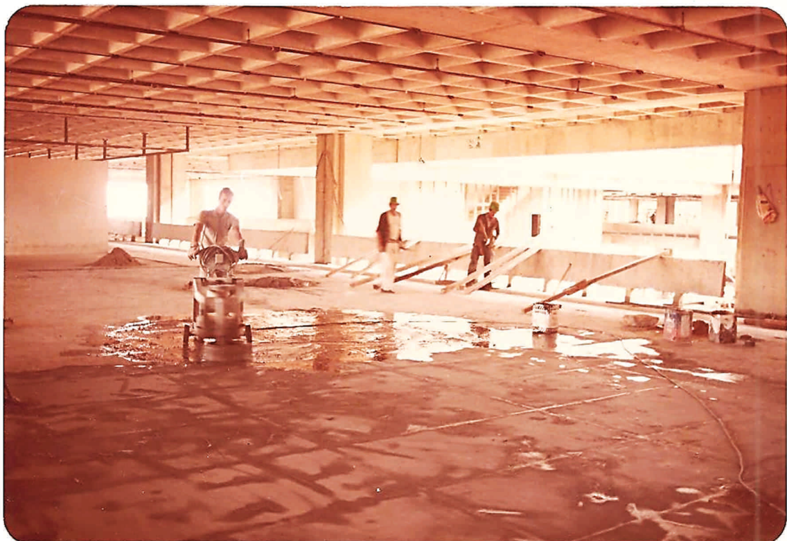
Foto 05 - Polimento do Piso de Cimento de Alta Resistência no Mezzanino - Setor 6.
