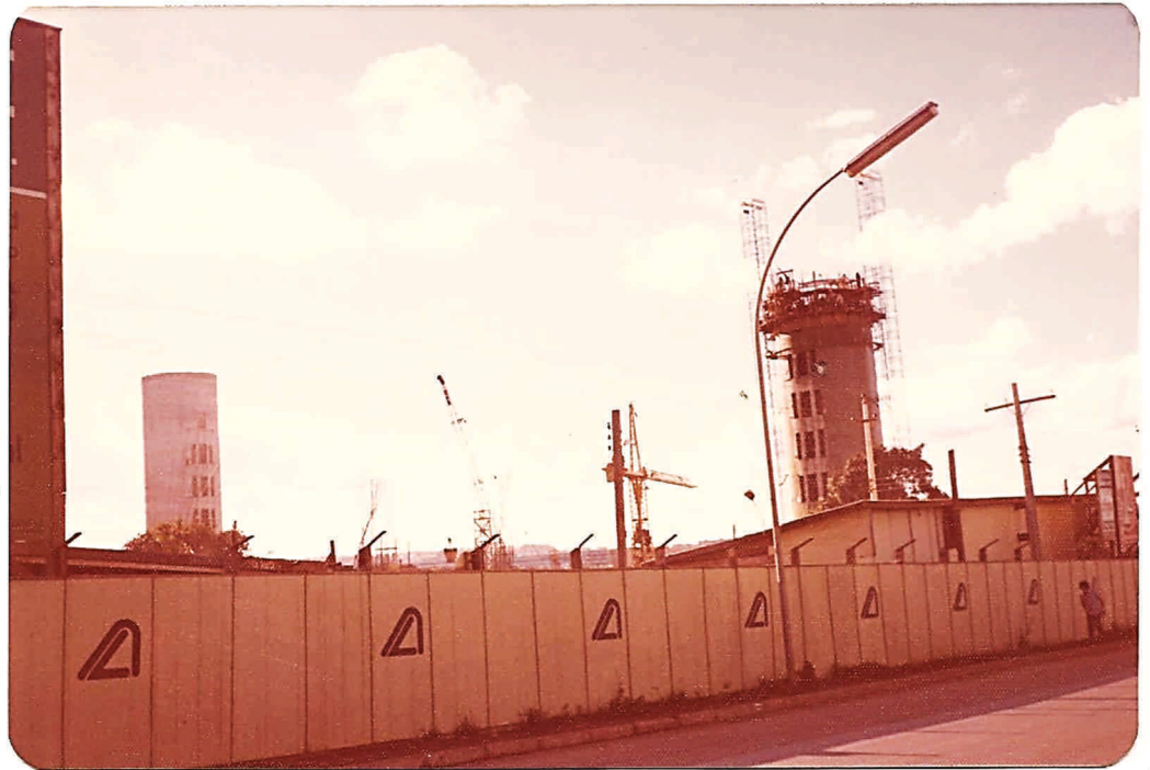
Foto 3 - Vista Externa das Torres 9 e 7 Concretadas com Forma Deslizante, Estando a Última em Final de Execução
