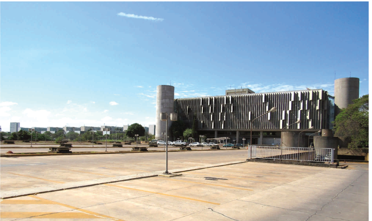
Figura 74 – Vista da face Leste, mostrando que poucas árvores se posicionam entre o edifício e a Via L2. Fonte: Foto do autor.
