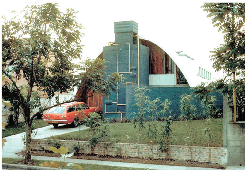
Figura 44 - Residência Dino Zammataro, São Paulo (1970). Projetada por Rodrigo Lefèvre, essa abóbada possui uma curvatura diferente das anteriores, sendo mais fácil de ser calculada matematicamente. Fonte: GUIMARÃES, 2006.
