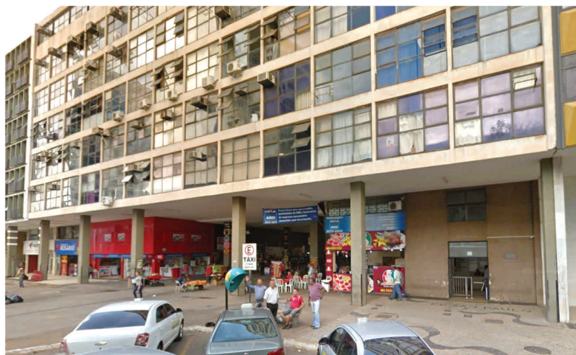
Figura 16 - Edifício São Paulo atualmente. Como solução de fachada, ambos os edifícios utilizam essa esquadria em malha quadriculada, preenchendo o vão entre as lajes. Fonte: Imagens Google
