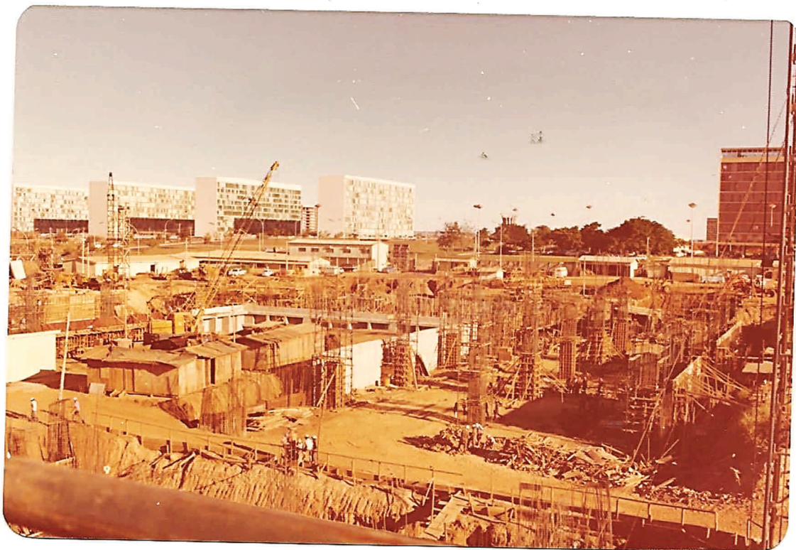
Foto 1 - Edifício-Sede - Prédio Principal Panorama dos Setores 3 e 6
