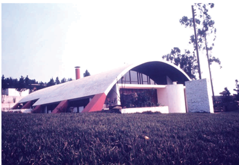
Figura 28 - Residência Bernardo Issler, em Cotia (SP). Neste projeto, Rodrigo Lefèvre e Sérgio Ferro organizaram o programa de necessidades sob uma estrutura em abóboda, que funciona como parede e como cobertura. Fonte: arquigrafia.org.br
