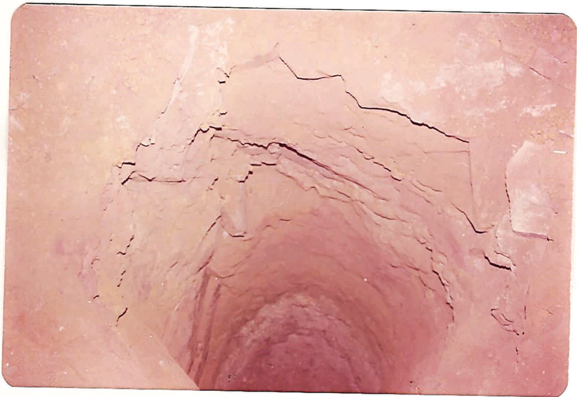
Foto 2 - Edifício-Sede - Prédio Principal - Vista da Pesquisa Escavada em Solo, até Provável Cota de Assentamento do Tubulão T-1 H (II). Nota-se a Grande Quantidade de Blocos e Placas Rochosas Escavadas no Trecho Superficial na Pesquisa
