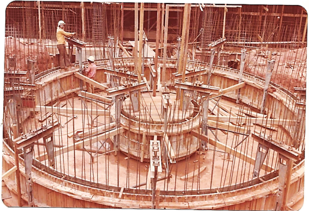
Vista Geral da Montagem da Forma Deslizante da Torre 4
