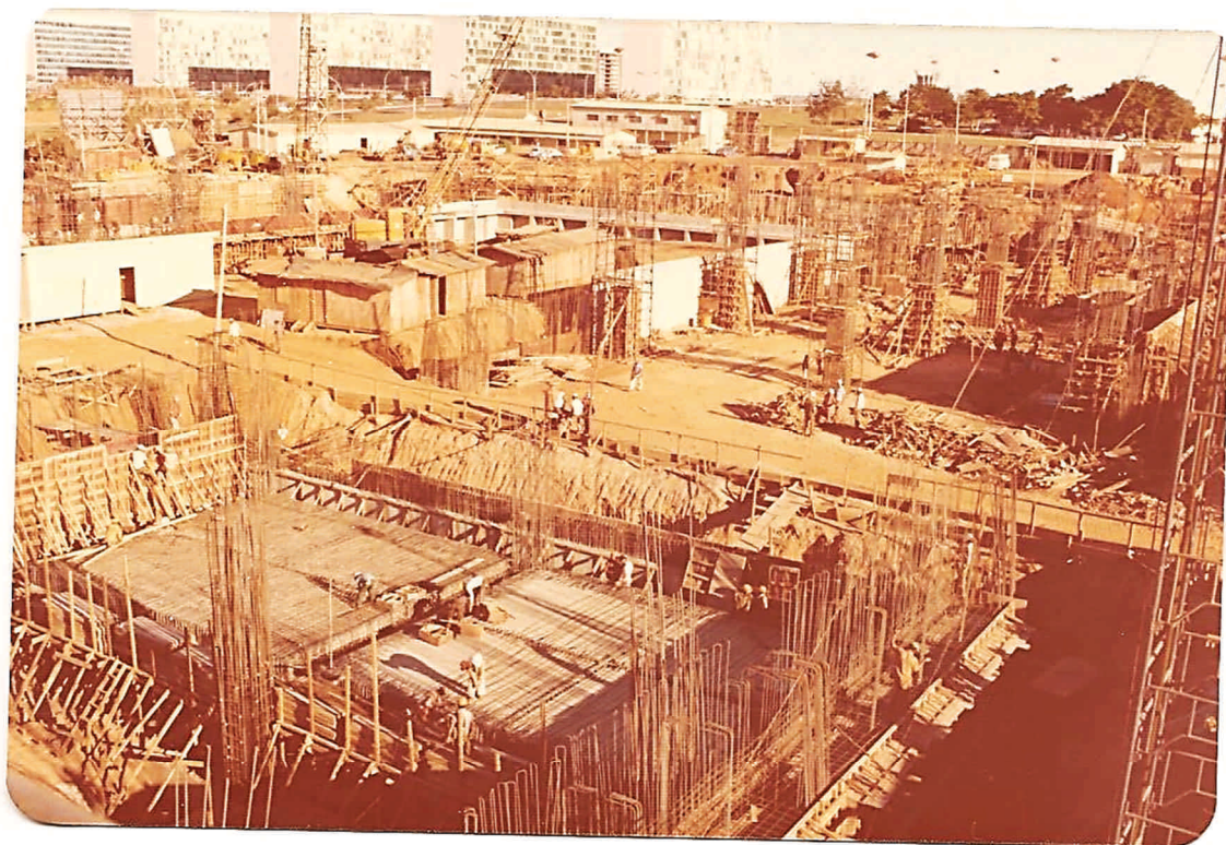
Foto 2 - Edifício-Sede - Prédio Principal - Vista da Armação da Laje Superior da Caixa d'Água do Setor 9
