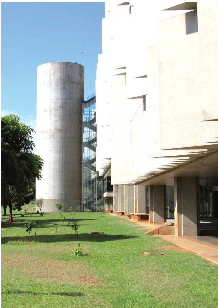
Figura 99 - Torre de serviço e caixilharia que abriga as escadas de acesso. Dois volumes em concreto aparente (a torre e a “caixa” principal) conectados por um volume em vidro transparente, que permite a visualização através, estendendo ao plano vertical a relação entre cheios e vazios presente no térreo. Fonte: Foto do autor.
