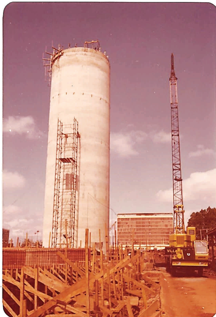
Foto 4 - Torre 9 - Concretada com Forma Deslizante
