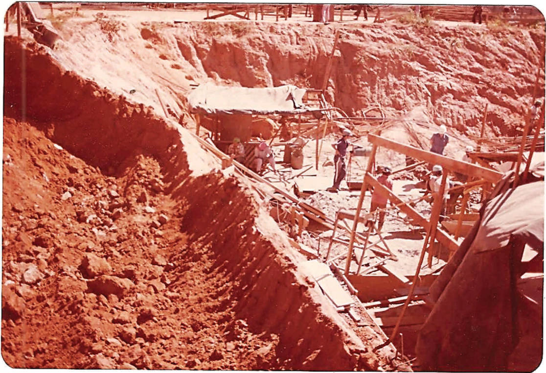
Foto 1 - Edifício-Sede - Prédio Principal - Aspecto da Escavação a Fogo do Tubulão T-1 H (II) e Mecânica na Área de Serviço da Torre 4
