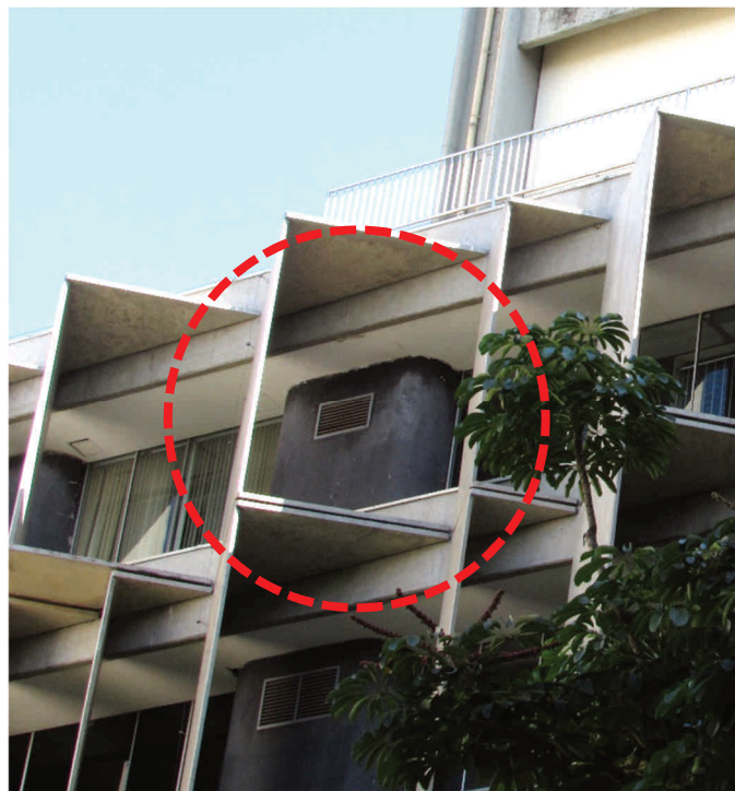
Figura 66 - Em destaque o módulo dos sanitários privativos, que podem ser localizados em qualquer ponto das passarelas que circundam os pavimento-tipo. Fonte: Foto do autor
