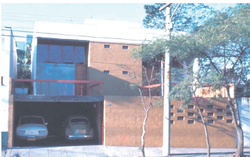
Figura 21 - Rodrigo Lefèvre e Sérgio Ferro projetaram em 1962 as casas de Marieta e Ruth Vampré, em São Paulo. A composição da fachada é marcada pelo contraste entre empenas quase cegas e grandes aberturas, em um jogo de planos que avançam e recuam, de espaços que mostram e que escondem. Fonte: GUIMARÃES, 2006.
