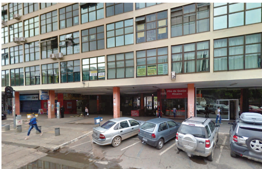
Figura 15 - Edifício Goiás atualmente. O térreo livre proporciona a integração entre ele, a via e os edifícios lindeiros. Fonte: Imagens Google
