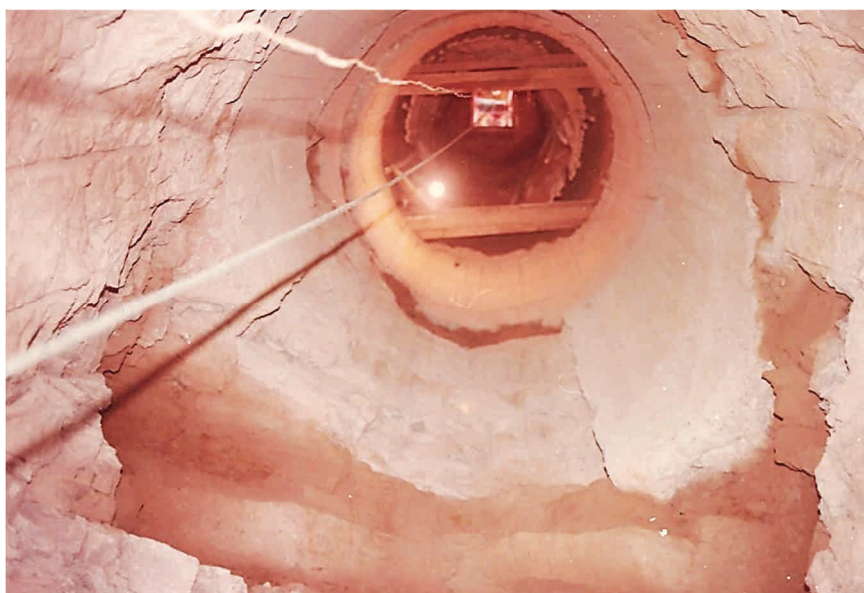
Figura 79 - Operários trabalhando na escavação da obra do edifício-sede do DNIT. Fonte: D.N.E.R. – Relatório de Produção e Progresso, 1976
