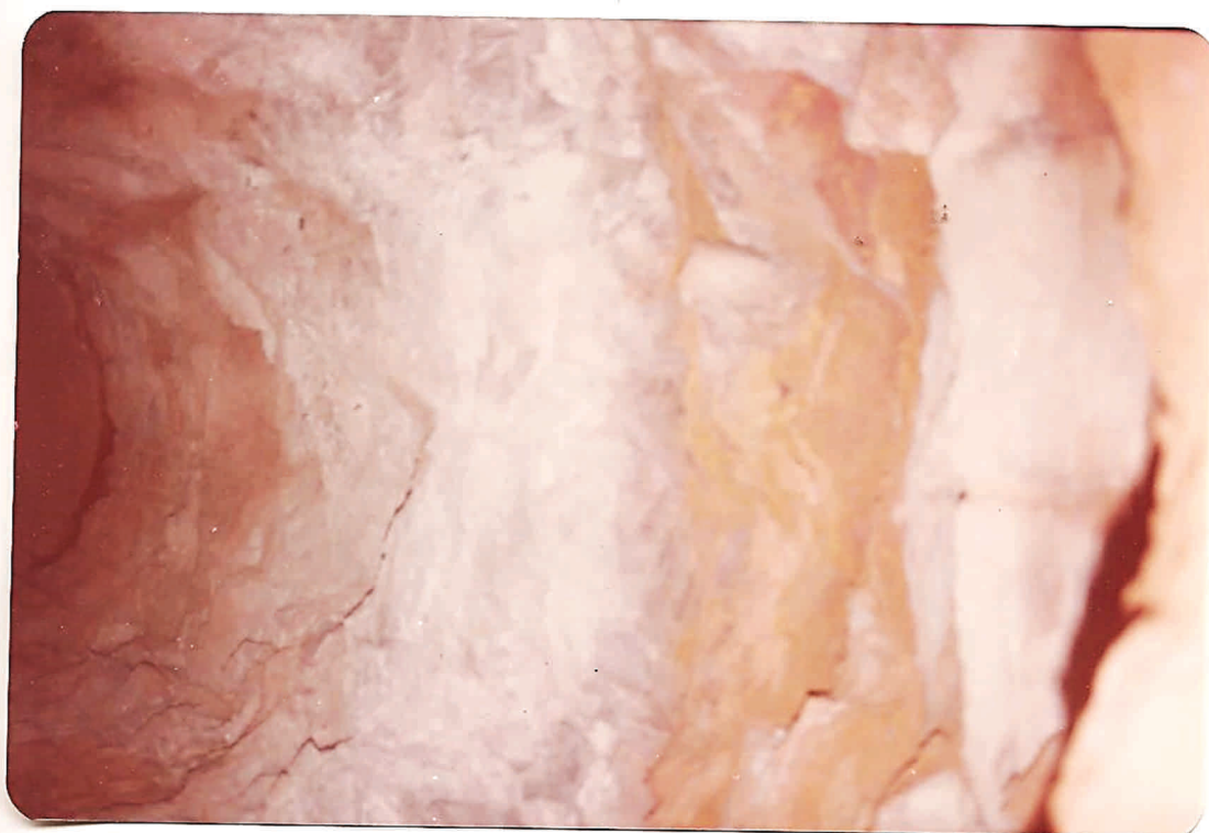
Foto 9 - Edifício-Sede - Prédio Principal - Detalhe da Camada Rochosa Ultrapassada e Transição Solo/Rocha nas Paredes de Fuste do Tubulão T-1 H (II)
