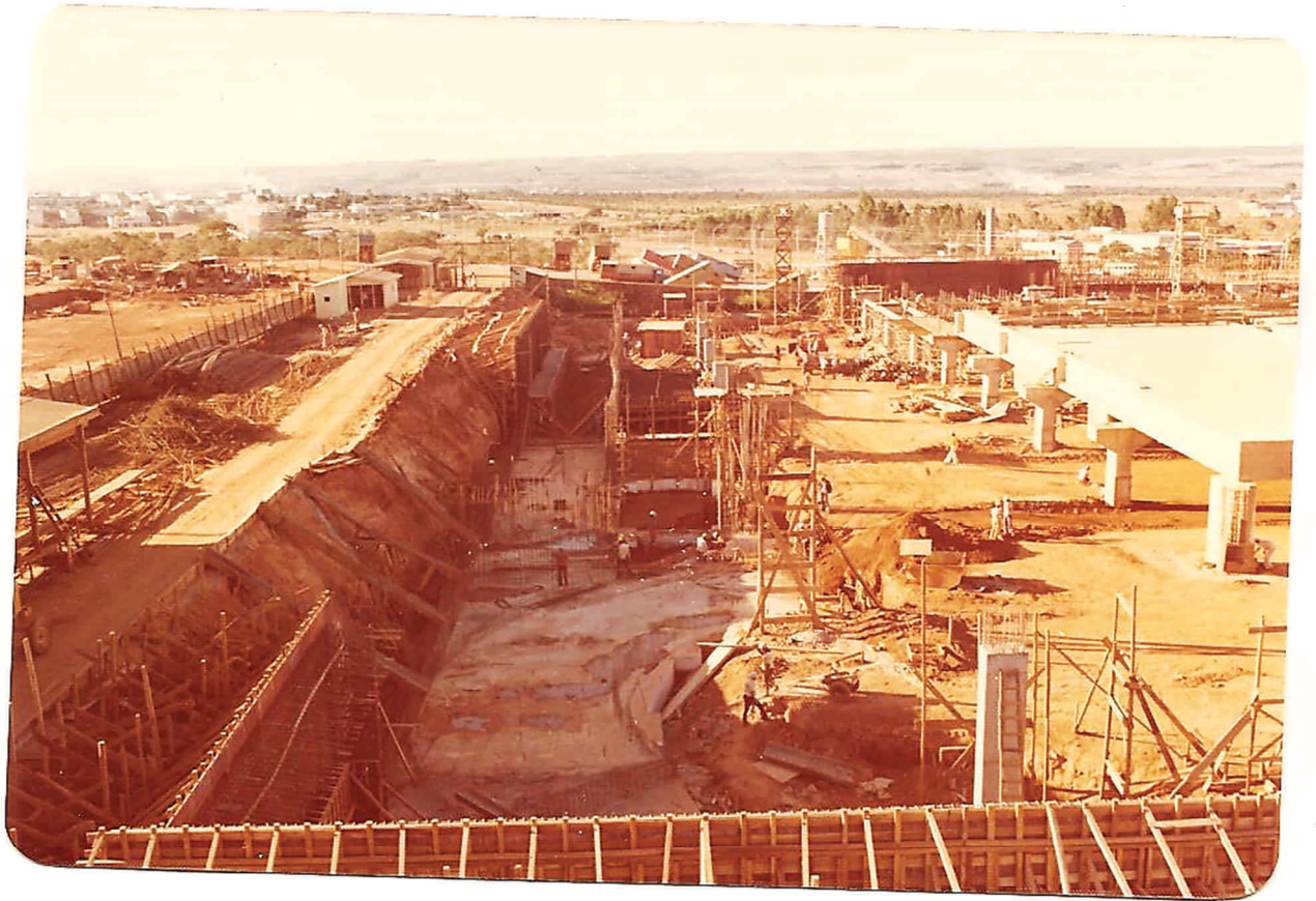
Foto 8 - Edifício-Sede - Estacionamento - Vista Parcial com Aspectos das Vigas e Lajes, Nível 1.063,35 entre Eixos P e PN já Concretadas
