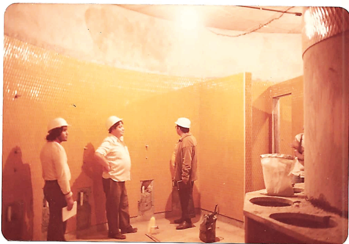
Foto 06 - Aplicação de Pastilhas de Cerâmica Esmaltada nos Sanitários das Torres.
