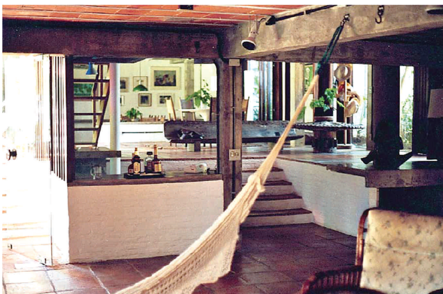
Figura 47 - Vista interna da Residência Thomas Farkas. Nota-se instalações aparentes, alguns materiais sem acabamento e a diferença de nível entre os pisos. Fonte: GUIMARÃES, 2006.
