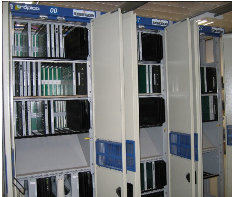
Figura 4.24 – Central Trópico-RA utilizada nos testes para geração de feixe E1.
