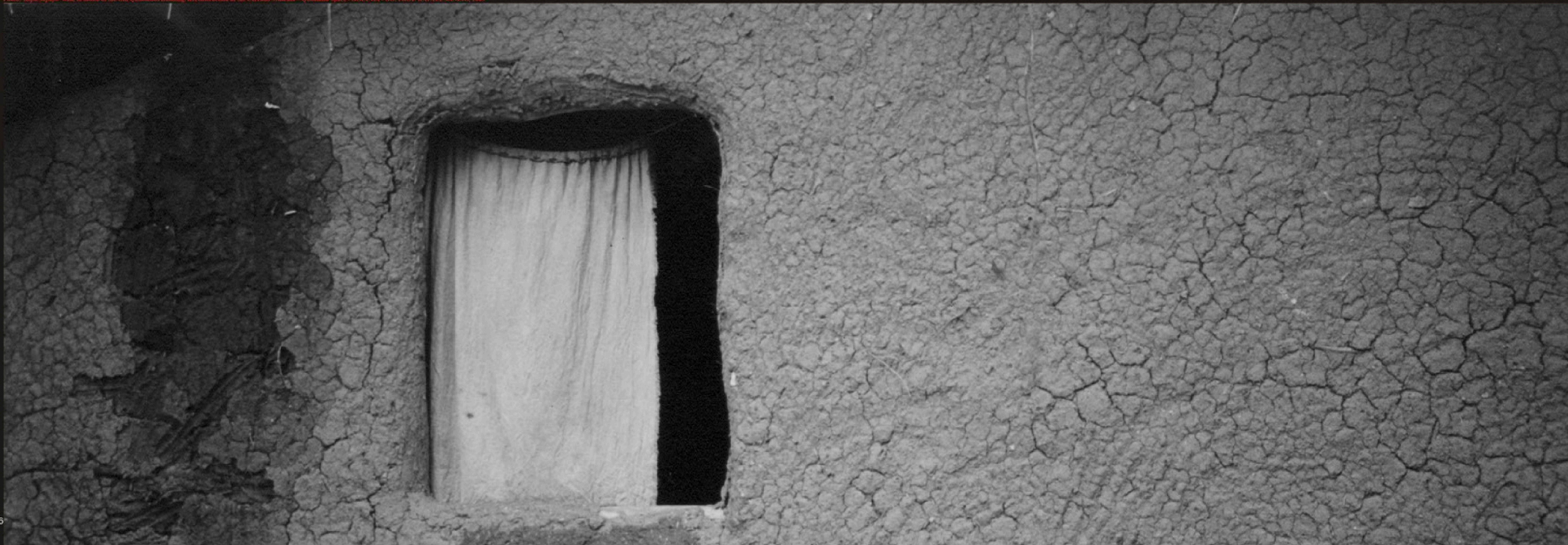
FOTO: TIPO DE PAREDE DE TAIPA OU SUIPAPO EXISTENTE NA MAIORIA DAS HABITAÇÕES DOS ANTIGOS QUILOMBOS NO BRASIL - RECONSTITUIÇÃO NO MUSEU DO CERRADO - ESPAÇO DO QUILOMBO - GOIÂNIA - GO. PROF. RAFAEL SANZIO, 2005 Photo: Type of wall of taipa or sui-papo existing in the majority of the Old Quilombos buildings. Reconstitution at the Cerrado Museum - Quilombo Space - GOIÂNIA - GO. PROF. RAFAEL SANZIO, 2005
