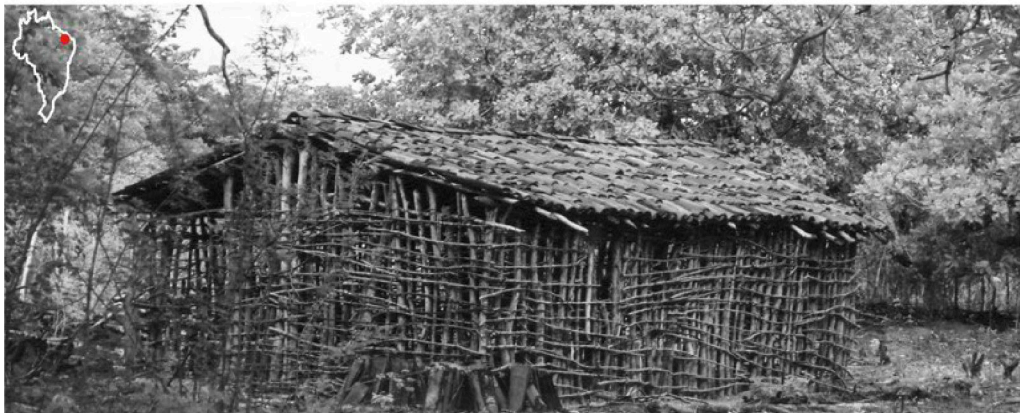
Foto: Estrutura de uma casa de pau a pique. Território de Conceição dos Caetanos, CE, 2006, Prof. Rafael Sanzio Photo: Pau a Pique house structure, Conceição dos Caetanos Community CE, 2006, Prof. Rafael Sanzio
