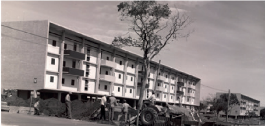
Figura 197 – Foto do Edifício RE recém-construído: expressão formal austera e significativa. Nota-se a execução de serviços de urbanização das ruas no seu entorno. Fonte: ArPDF
