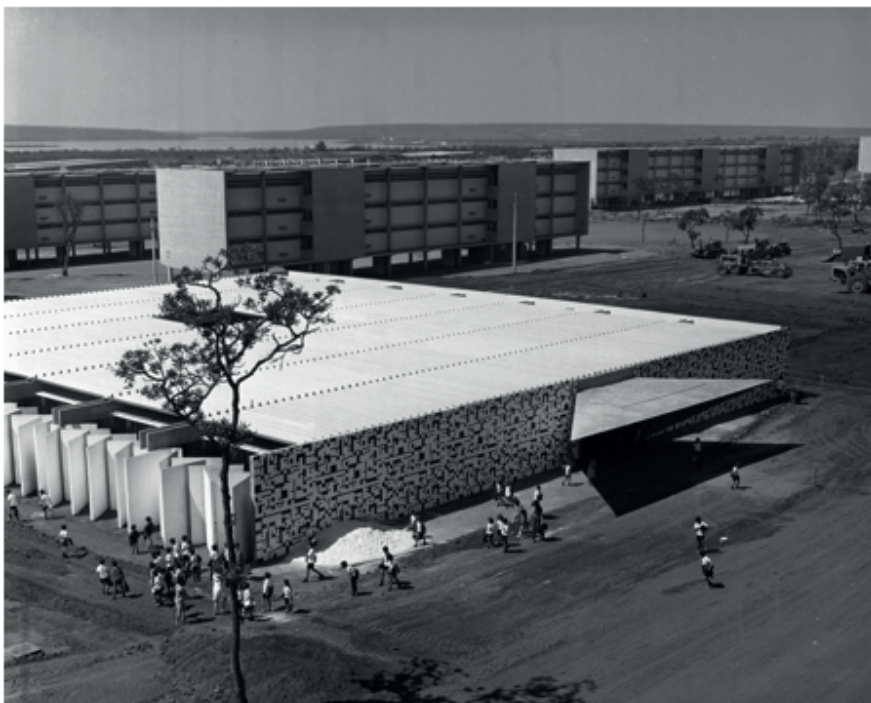
Figura 247 - Edifício da Escola Classe - história e pioneirismo na Asa Norte. Fonte: ArPDF.
