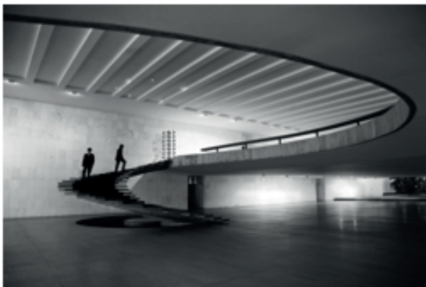
Figura 185 – Escada helicoidal em balanço – tipologia recorrente na arquitetura moderna brasileira. Nas três fotos mais ao alto: escadas no MAM, no Sede I e no Teatro Nacional de Brasília. Abaixo destas, a escada do Palácio do Itamaraty – aprimoramento do desenho com tecnologia e delicada leveza. Fonte: Portal Vitruvius.
