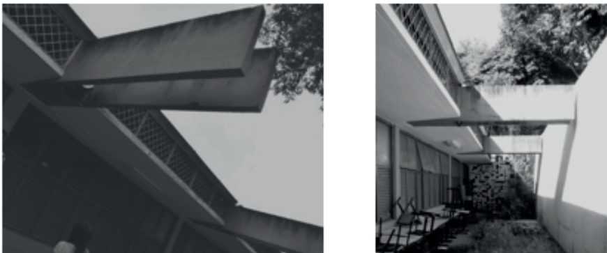
Figura 228 – Fotos das vigas-calhas no edifício da Escola Classe 407/8.
