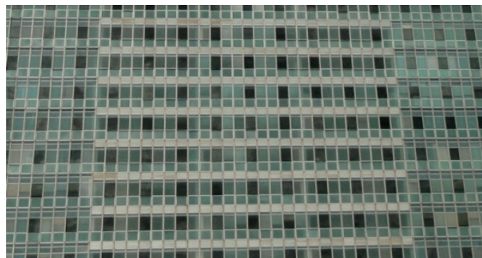
Figura 88 - Trecho de fachada envidraçada do Sede I. Foto JWJ (2012).
