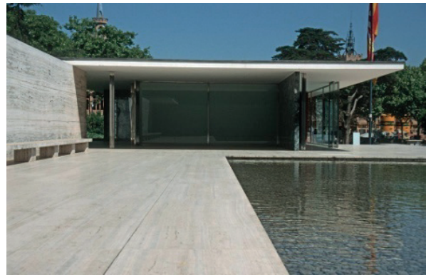
Fig. 18 - Pavilhão Alemão de Mies van der Rohe, antes e após reconstrução. Fonte: Pinterest.com.
