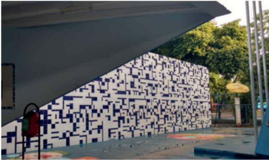
Figura 180 – Área de acesso da Escola Classe 407/8.
