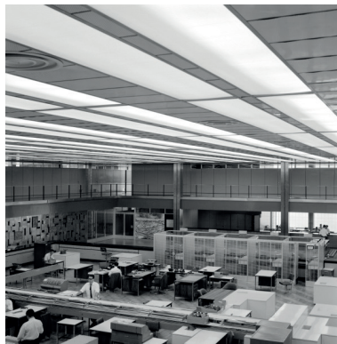
Figura 123 – Alterações no saguão de acesso do edifício. Problemas de segurança provocaram a separação do acesso de funcionários do acesso de clientes e o deslocamento do balcão de recepção. Fotos: Marcel Gautherot (1960) /Acervo Instituto Moreira Salles e JWL (2012).
