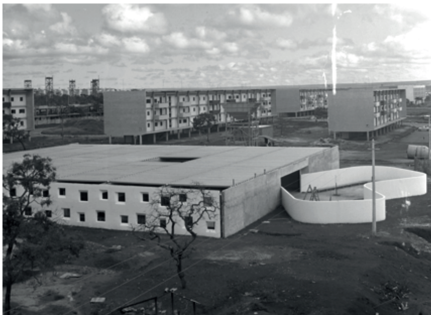
Figura 217 – Foto da Escola Classe 407/8, em fase final de obra; a escola como ideia urbanística estruturante da superquadra. Fonte: ArPDF.
