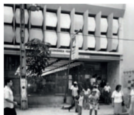
Figura 145 - Agências bancárias: Conjunto Nacional, Planaltina e Sobradinho (Brasília) e Rua do Comércio (Maceió). Fonte: acervo Marcílio Mendes Ferreira
