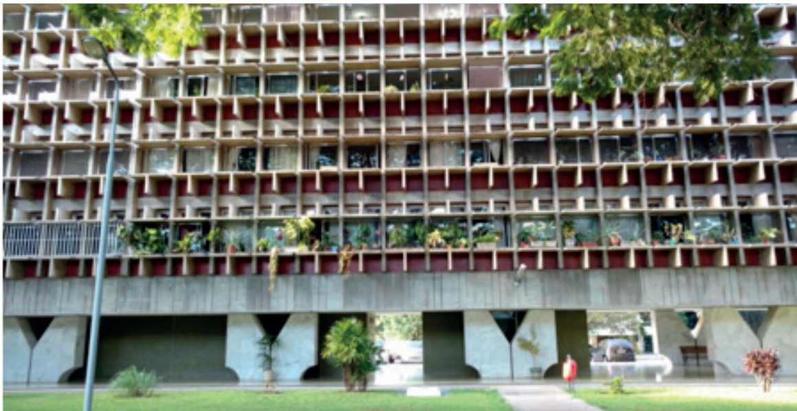
Figura 174 - Imagens das diferentes e complementares texturas do edifício A-22.
