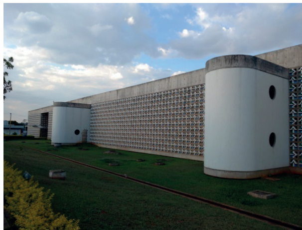
Figura 155 - Instituto de Química da UnB: projeto em parceria com Aleixo Furtado e equipe, construído em 2008, no Campus Asa Norte. Vista da portaria frontal e detalhe de cobogós.
