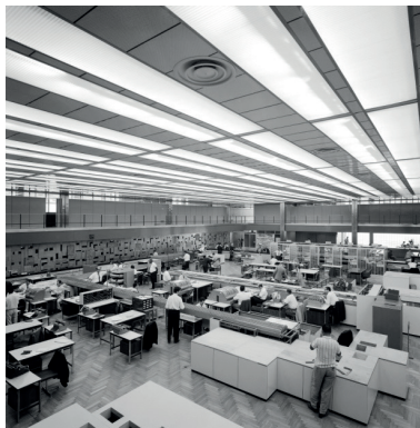
Figura 116 - Fechamento de sheds e descontinuidade da iluminação – a oscilação da luminosidade no ambiente de trabalho da agência gerou inúmeras reclamações de funcionários e provocou a alteração. A opção de fechar os sheds que compunham a iluminação zenital contínua no salão do térreo traz grande impacto formal na concepção de Garcia Roza. Fotos: Marcel Gautherot (1960) /Acervo IMS, à esquerda, e JWL (2012), à direita.
