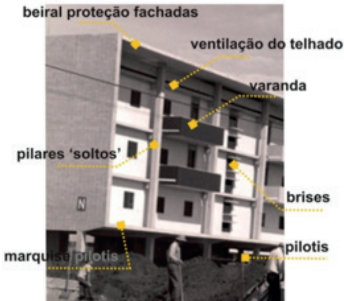
Figura 194 – Esquema das soluções espaciais e técnicas de Milton Ramos para os blocos RE. Fonte: destaques nossos sobre foto do ArPDF.
