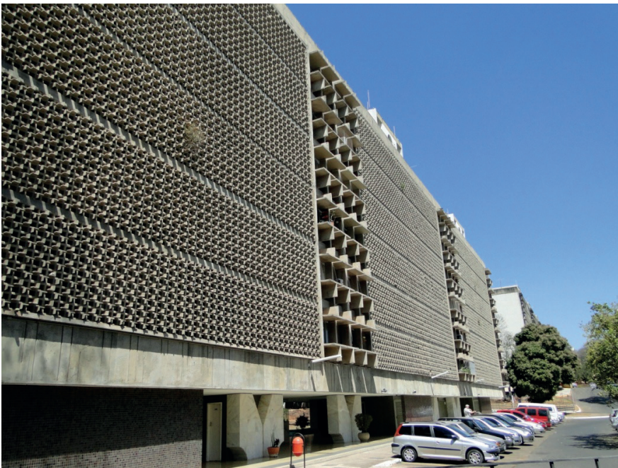
Figura 169 – Fachada posterior e detalhe de cobogó do A-22. Fonte: acervo Marcílio Mendes Ferreira.
