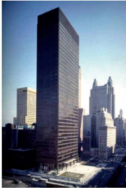
Figura 65- O edifício Seagram, de Mies van der Rohe, à esquerda; à direita, o Lever House, de Bunshaft – referências tipológicas de edifícios corporativos dos anos de 1950. Fonte: Pinterest.
