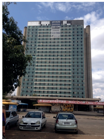
Figura 139 – Edifício Sede I com placa anunciando sua disponibilidade para locação.
