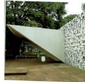
Abrigo - marquise acesso
