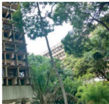
Figura 178 - A-22 e espaços internos da SQN 206 – integridade e consolidação da ideia de superquadra.
