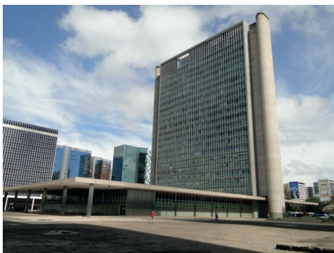
Figura 115 - Alteração na composição do edifício decorrente de legislação de segurança – escadas de incêndio inseridas na cortina vertical de concreto, em 1997/98. Essa é a intervenção de maior interferência na composição original do edifício, embora, a nosso ver, feita com certa parcimônia e qualidade, minimizando os prejuízos. É fácil verificar como esse tipo de intervenção pode ser desastroso observando a inserção de escada de incêndio, feita posteriormente, no edifício do BRB, de MM Roberto, no próprio SBS. Fotos: Marcel Gautherot (1960) /Acervo Instituto Moreira Salles(IMS) e JWL, 2012.
