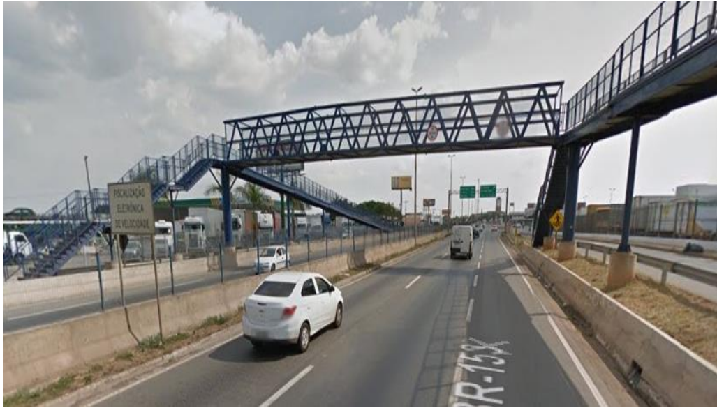
Figura 6.1 - Passarela metálica da BR 153 em Goiânia (Google™, 2017) Google Earth. Acesso em: 15 de fevereiro de 2017.
