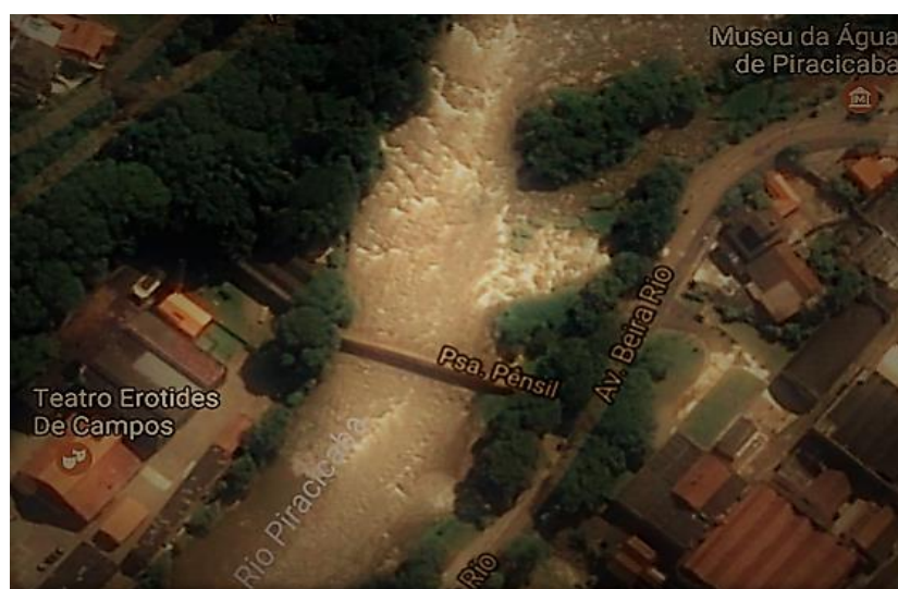
Figura 6. 21 - Vista área da Passarela Pênsil de Piracicaba. Google Earth. Acesso em: dezembro 2016.
