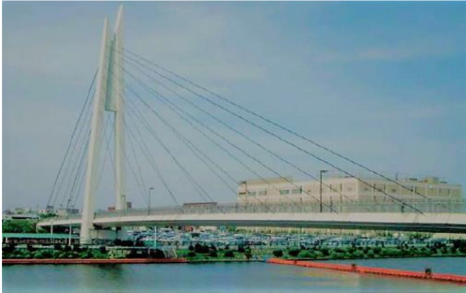
Figura 2.11 - Passarela Toda Park, Japão (Ingólfsson et al. , 2012).
