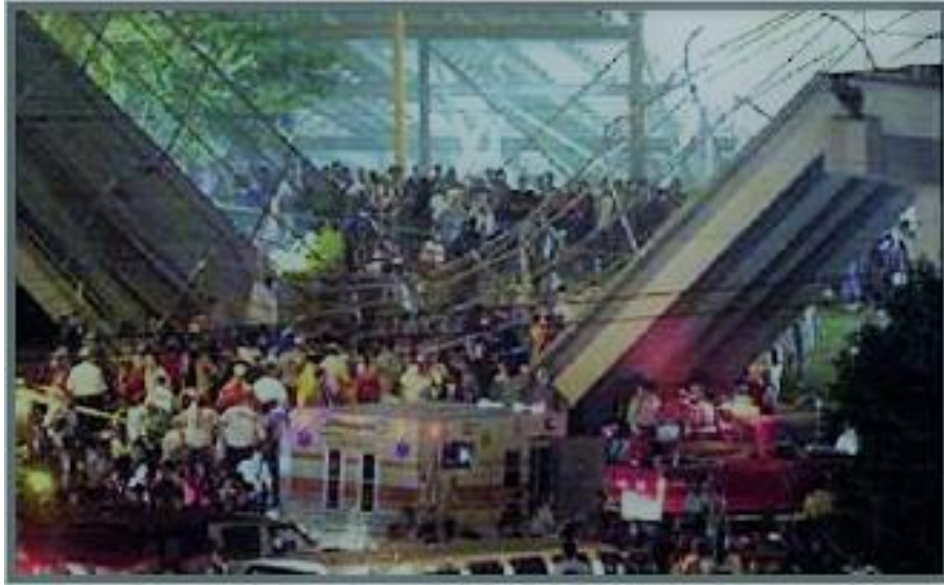
Figura 2.13 - Passarela na Carolina do Norte/EUA instantes após o desmoronamento. http://www1.folha.uol.com.br/fol/inter/ult21052000.htm . Acesso em: 21 de abril de 2016
