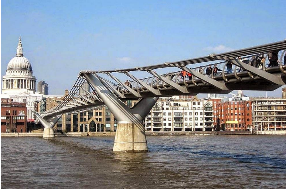
Figura 2.6 - Passarela Millenium, Londres, Inglaterra http://britainexplorer.com/listing/millennium-bridge/ . Acesso em 21 de abril de 2016.
