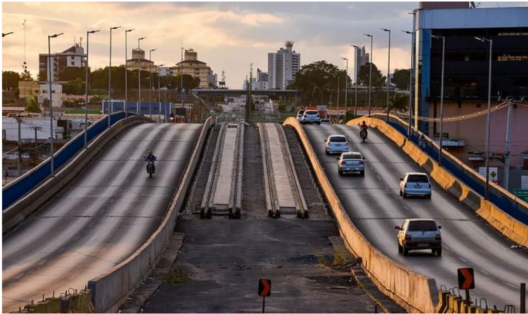
Figura 9.8. Obra VLT de Cuiabá Fonte: Lucas Ninno/Gcom
