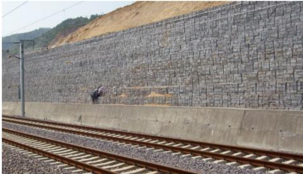
Figura 2.3. Barreira rígida de gabião (MACCAFERRI, 2017).
