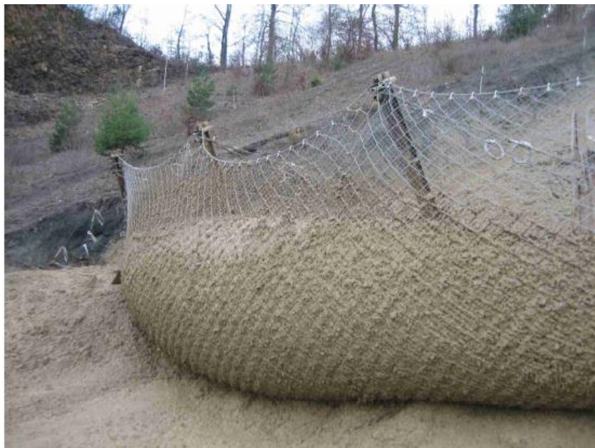
Figura 2.2. Barreira flexível contendo 71 m 3 de material (Von Boetticher et al. 2011).
