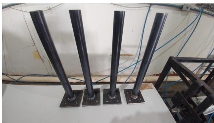
Figura 89 - Tubo de 1" soldado a chapa que será parafusada a plataforma.
