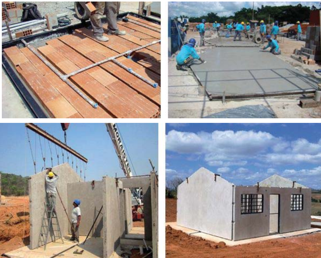
Figura 38: Painel de tijolos cerâmicos
