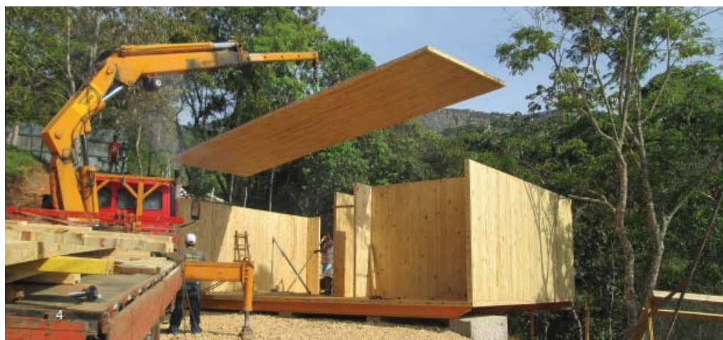
Figura 27: Montagem de painéis CLT
