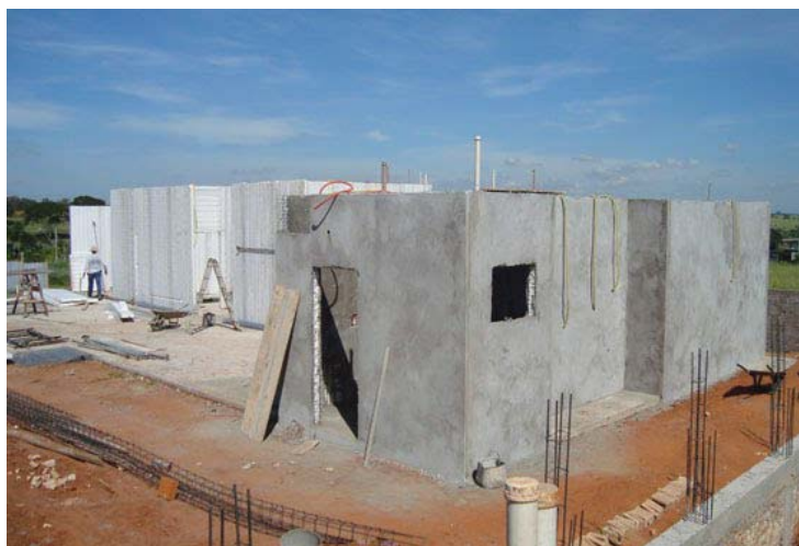
Figura 36: Vedação em placas de EPS e argamassa armada
