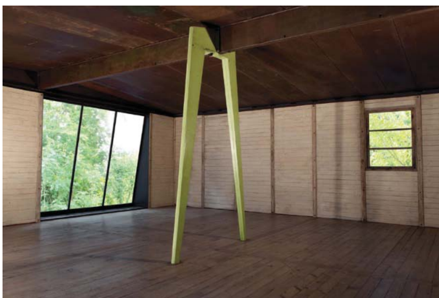
Figura 25: O pilar em formato de compasso, estrutura principal da casa 8x8m
