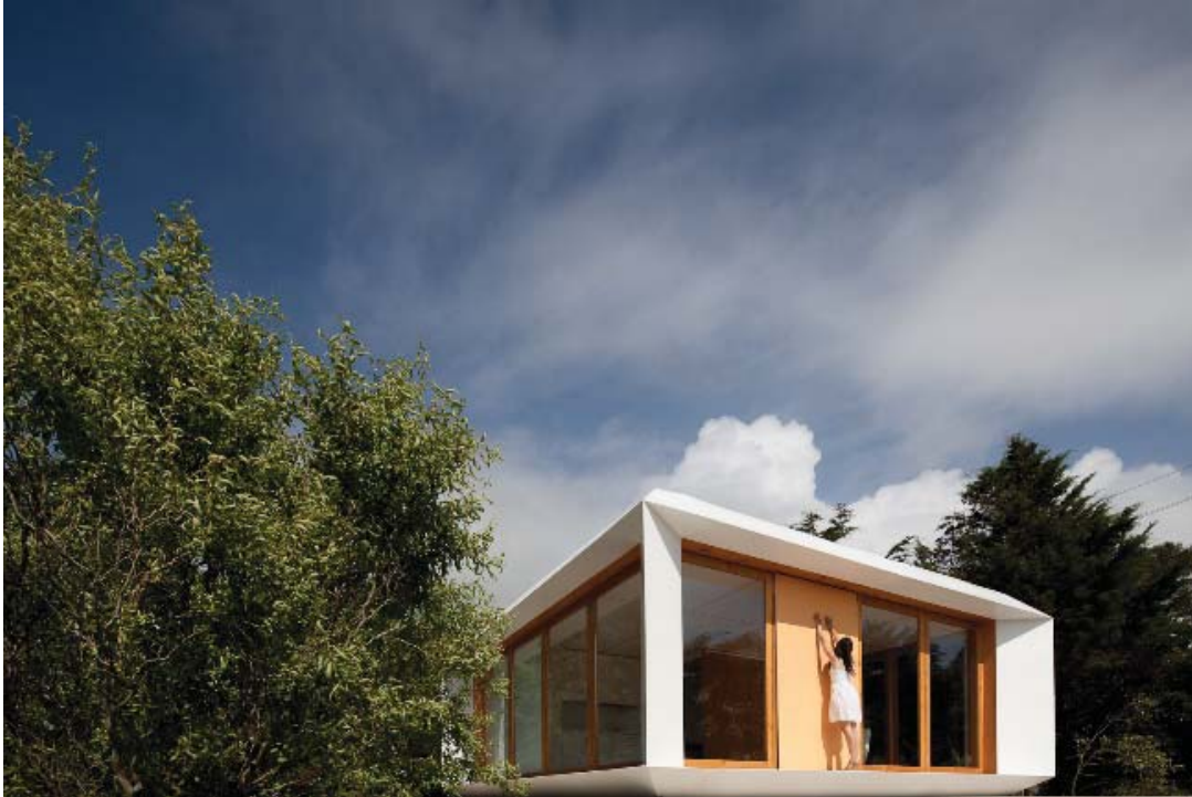
Figura 41: Vista externa da Mima House
