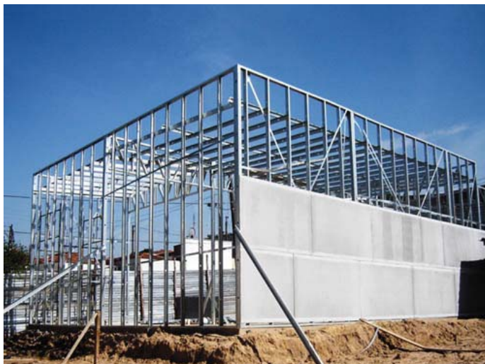
Figura 35: Vedações em placas cimentícias e placas de gesso acartonado
