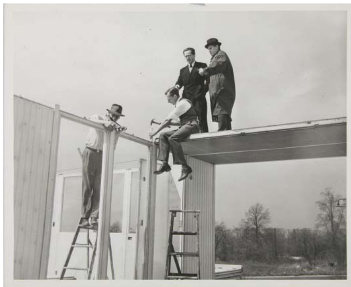
Figura 23: montagem do protótipo da Packaged House
