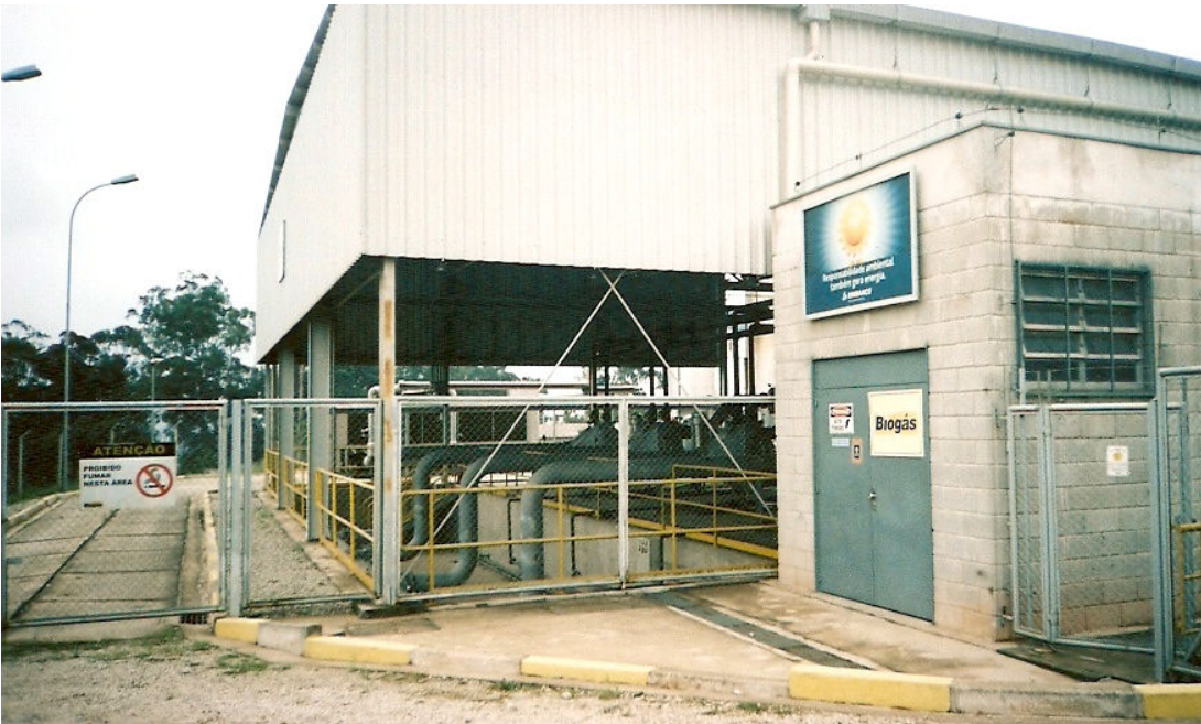
Usina de Biogás
