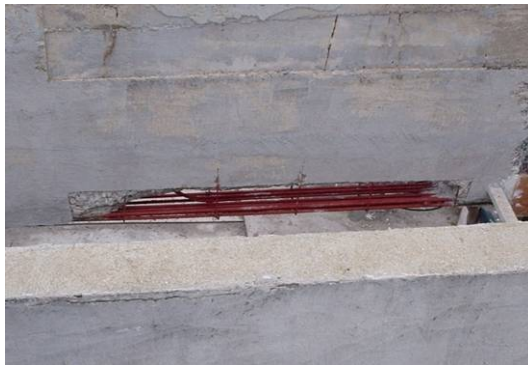
a) Armaduras com primer aplicado
