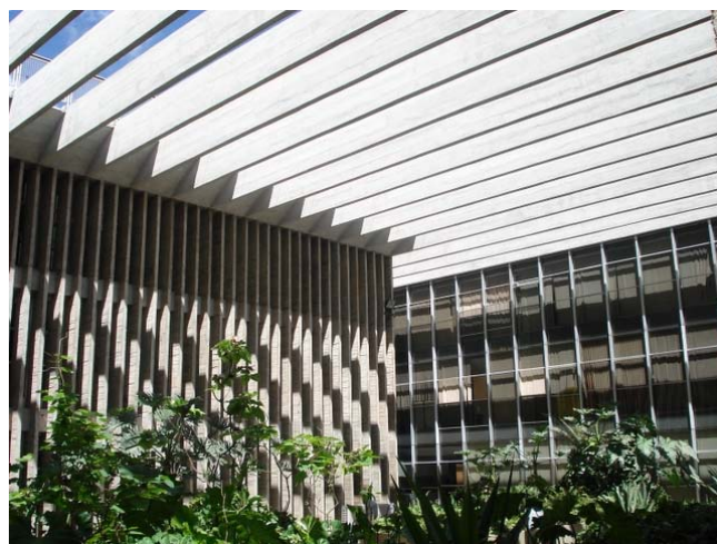
Figura 5.17 – Vigas do pergolado, jardim interno, após a recuperação
