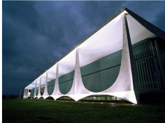
Figura 2.3 – Detalhe dos pilares da fachada do Palácio da Alvorada
