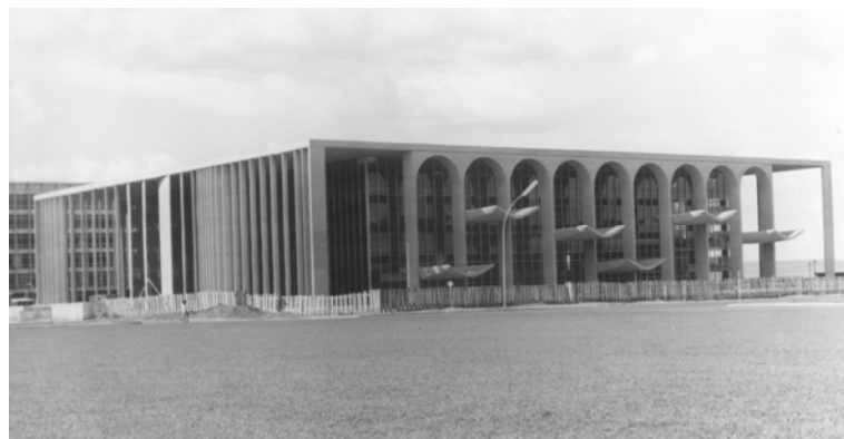
Figura 4.13 – Estrutura do Palácio da Justiça em fase final (Divisão de Obras – MJ)
