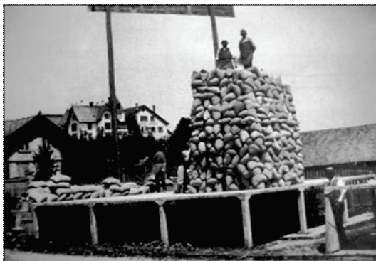
B Testes executados por Maillart (Furst e Marti (11))
