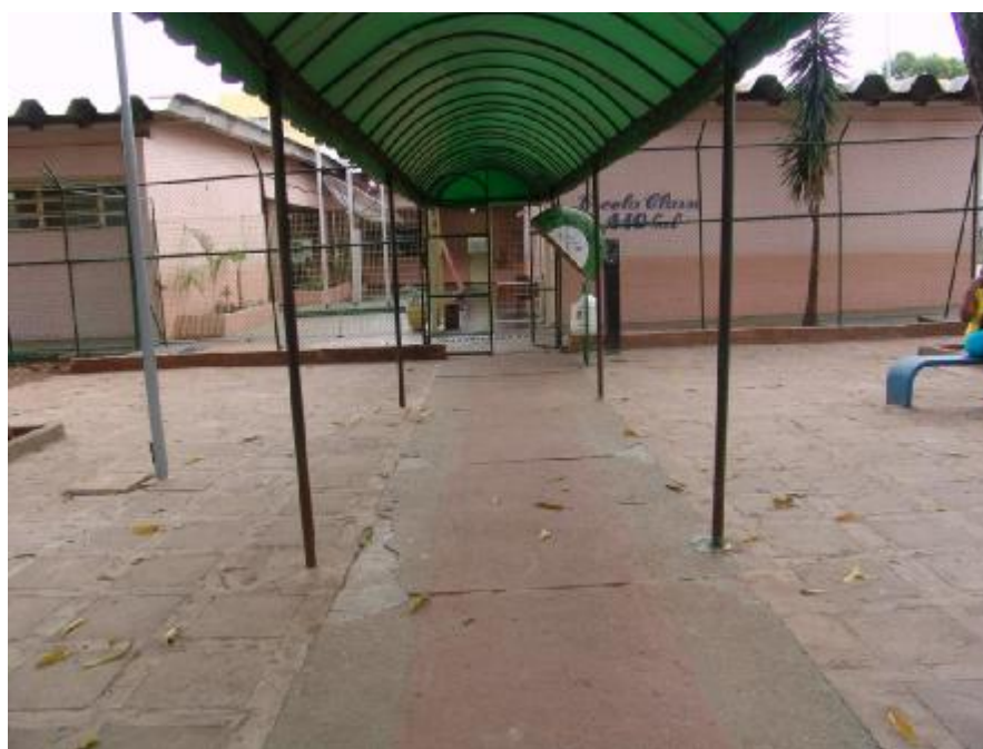
Fotografia 14. Acesso à Escola Classe 410 Sul
