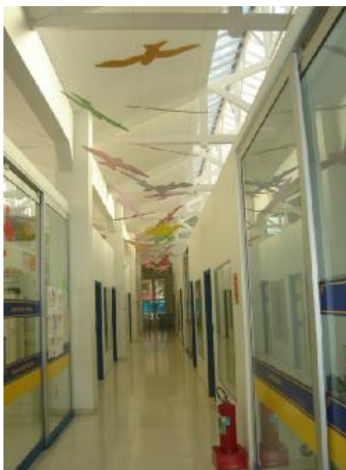
Fotografia 12. Corredores de circulação e acesso com iluminação zenital – Lote 680
