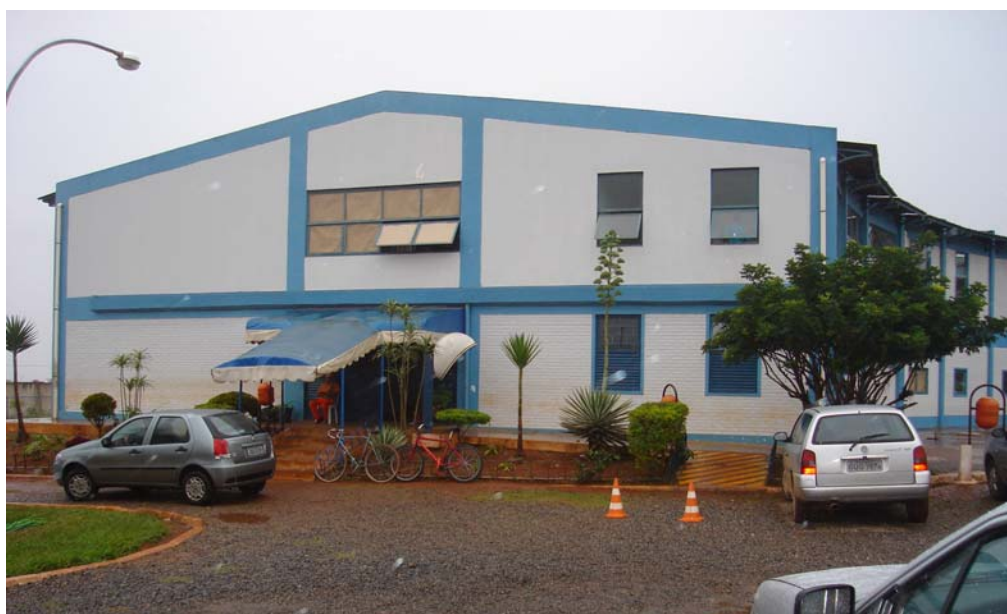
Figura 12 – Fachada do prédio da Biblioteca Pública de Ceilândia
