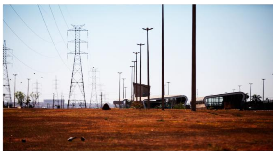
Fotos 05: Rede de alta tensão de FURNAS. Washington Candido, agosto de 2017.
