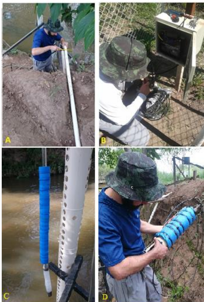
Figura 15: Instalação e melhoramento da infraestrutura: tubos PVC para passagem de fios ligados ao painel solar na foto A e instalação da bateria ligada ao painel solar na foto B. Fotos C e D instalação de infraestrutura para flutuação filtro do amostrador automático ISCO 6712 (C) e da sonda multiparamétrica Hydrolab DS5X (D). Foto: Elton Souza (2017a).
