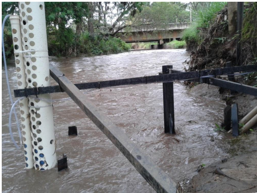
Figura 16: Estrutura para sonda e amostragem de sedimento com variação da cota e lance de réguas em funcionamento. Ao fundo, ponte que faz parte da rodovia DF-003 (Estrada Parque Indústria e Abastecimento – EPIA). A ponte encontra-se a montante da estação. Foto: próprio autor.
