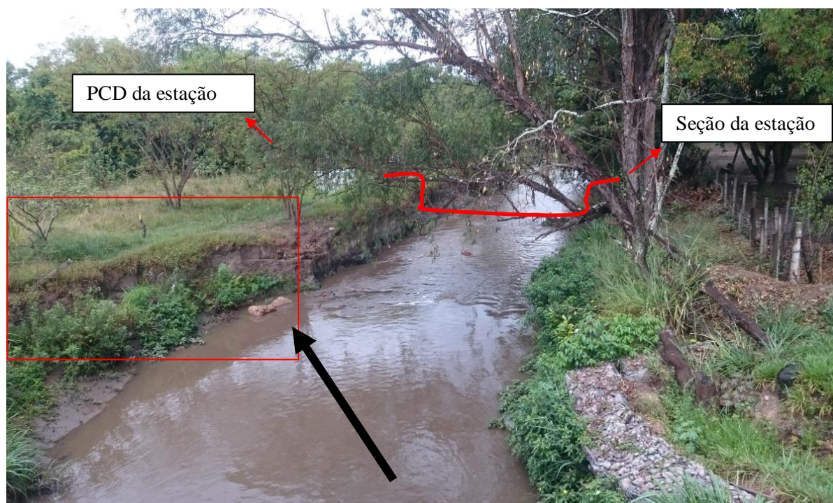
Figura 23: Foto do ano 2017 mostrando erosão na margem esquerda (retângulo vermelho), próxima à Estação Fluviométrica Riacho Fundo Montante Zoológico EPIA 003, Código ANA 60478200..Foto tirada de cima de ponte, localizada a montante da estação, na rodovia DF-003 (Estrada Parque Indústria e Abastecimento – EPIA) Foto: Elton Souza (2017b).
