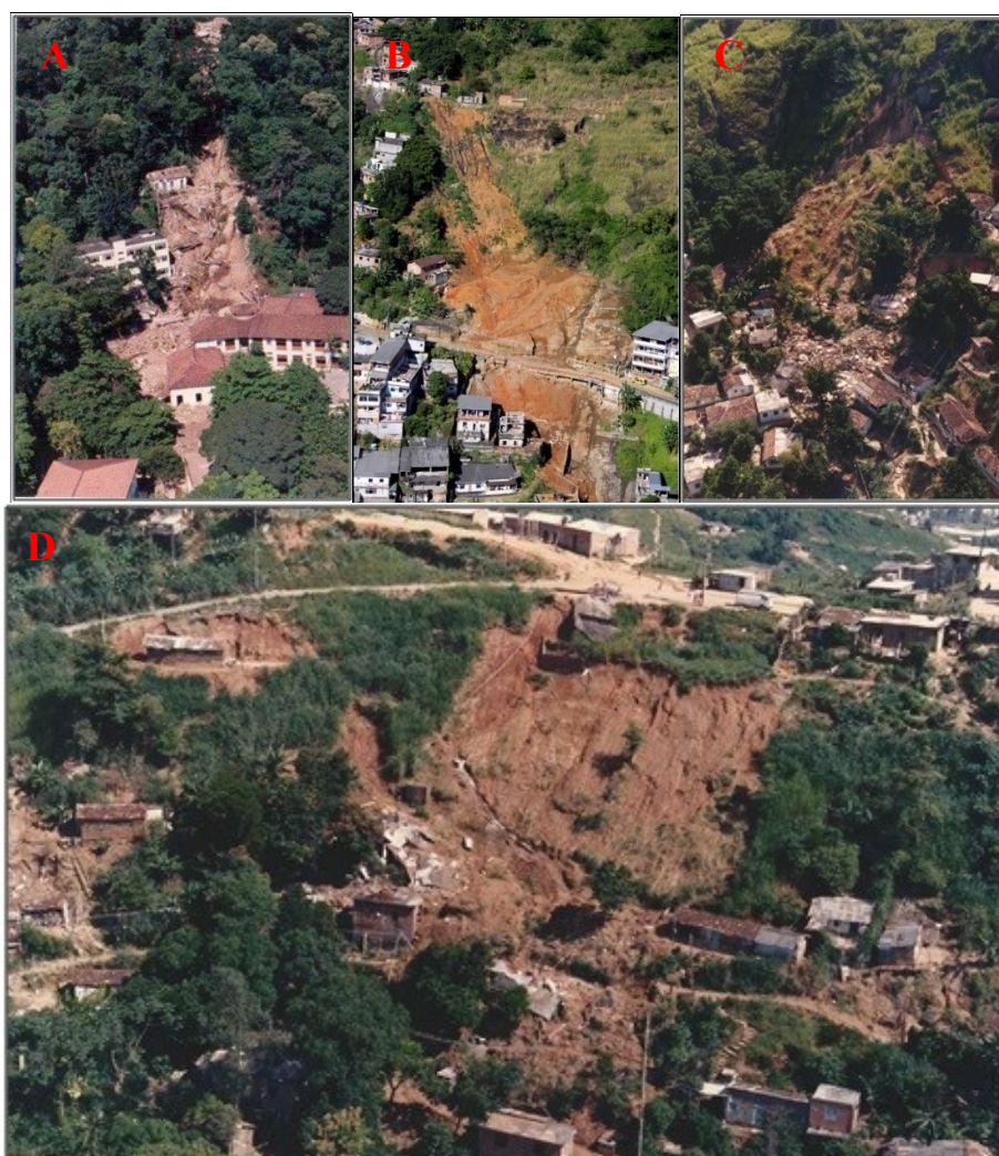
Figura 4.33 - Registro fotográfico de escorregamentos ocorridos no município do Rio de Janeiro nos anos de 1988 e de 2010. Foto A – cicatriz de um escorregamento de terra ocorrido na estrada Dom Joaquim Mamede, distrito de Santa Teresa, onde é possível perceber os danos provocados na área. Foto B – cicatriz de escorregamento ocorrido na Comunidade Morro dos Prazeres, também no distrito de Santa Teresa. Foto C – cicatriz de escorregamento e danos causados na Comunidade Parque Licurgo, distrito de Madureira. Foto D – cicatriz de escorregamento e danos causados na Comunidade Morro do Borel, distrito da Tijuca. Fonte das Fotos: Relatório Técnico da Fundação GEO – RIO, 2016.
