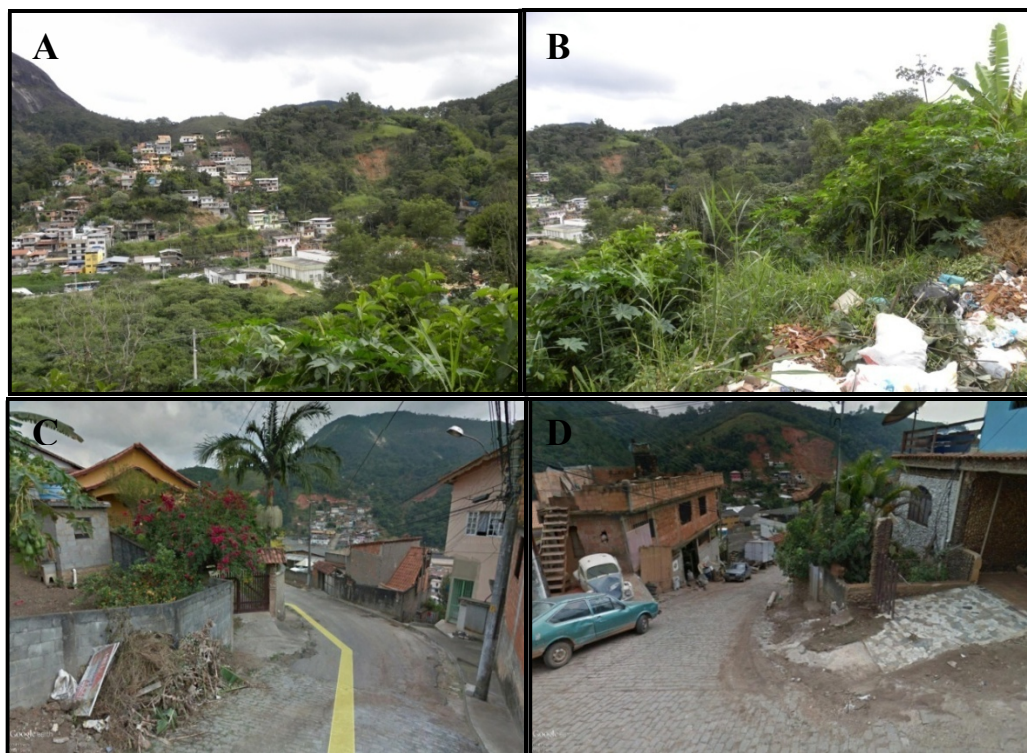
Figura 4.25 - Exemplos de ocupações de área de encosta em comunidades/assentamentos localizados no bairro Córrego D'Antas. Além da ocupação irregular de encosta (A, B, C, D) é possível constatar a presença de lixo (C e D) e as cicatrizes deixadas pelos escorregamentos ocorridos na área (A, B, C, D). Fonte: A e B fotos de arquivo pessoal, C e D Google Earth (15/07/2016).
