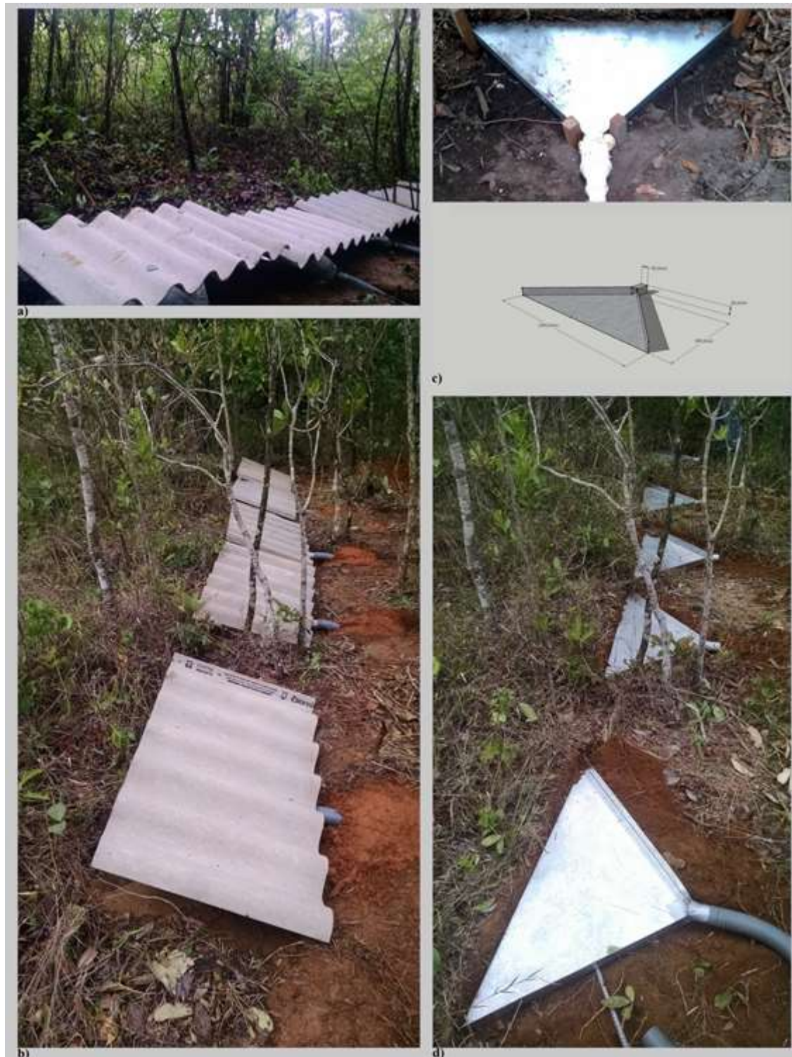
Figura 4.14 - Coletores de escoamento superficial. a) instalação na mata de galeria; b) instalação no cerrado sentido restrito; c) detalhe de projeto e instalação; e d) fase de instalação.
