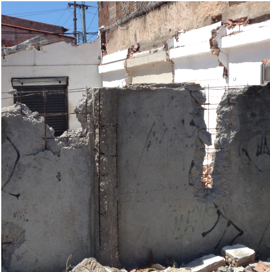
Figura 25: Entulhos na comunidade do Mucuripe. Fonte: acervo do autor.
