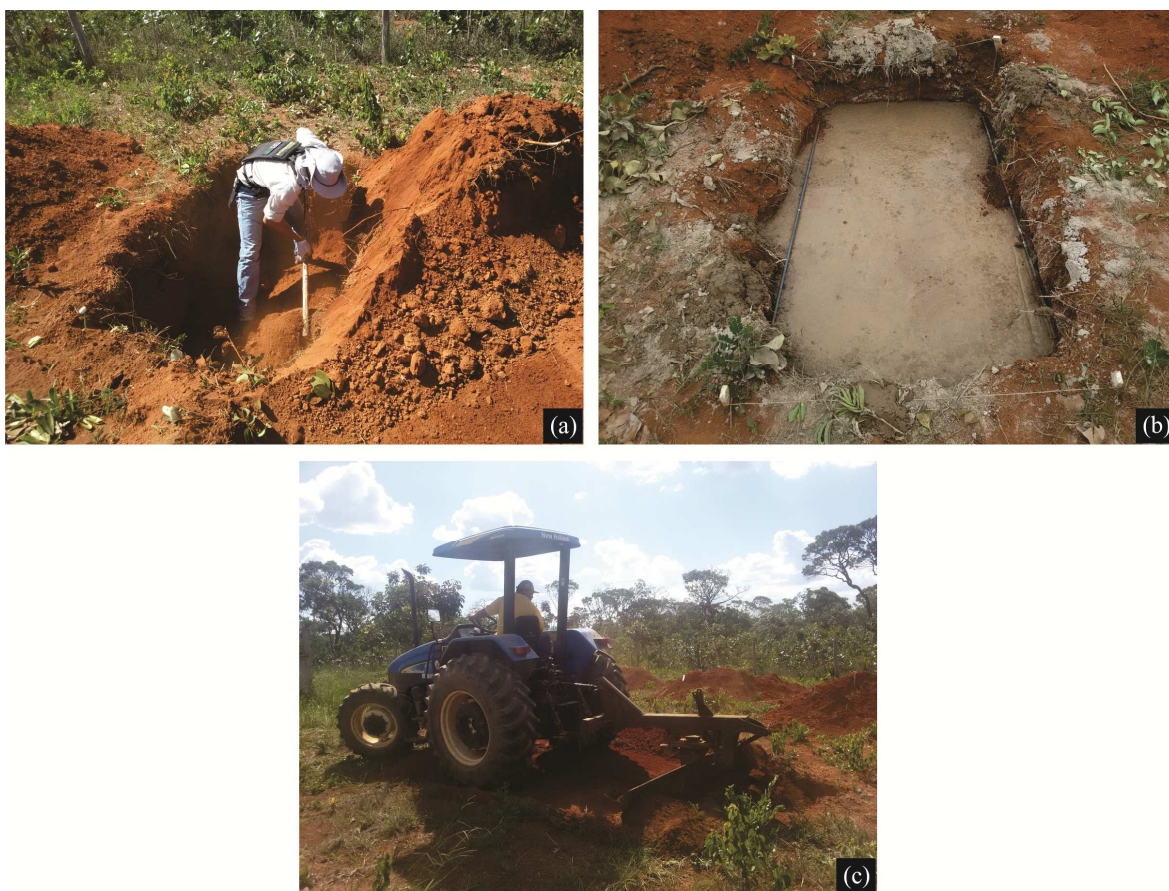
Figura 2.13 – (a) Trabalho manual com enxada no cobrimento do alvo. (b) Covas com os vergalhões dispostos nas laterais a uma profundidade de 0,25 m. (c) Uso do trator para finalizar o cobrimento da cova e nivelamento da área escavada.
