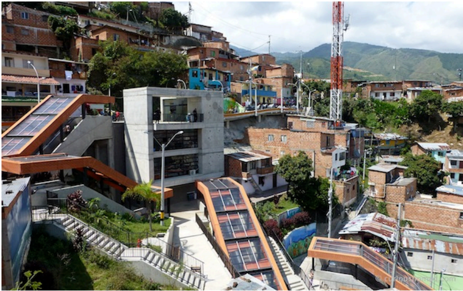
Figura 8 - Escadas elétricas comuna 13 Medellín.
