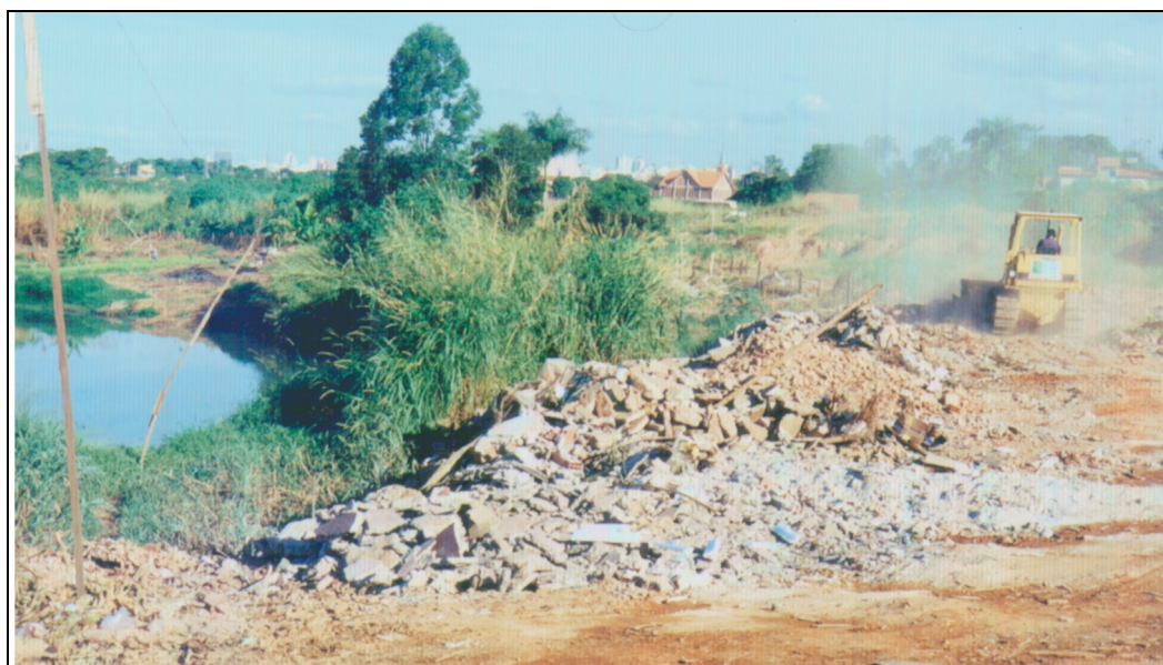
Imagem 3 – Aterro. Fonte: Bernardo Cristóvão Cunha (2000).
