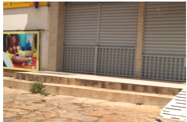
Figura 39 - Degraus na entrada de comércio Fonte: Autora (Fotos em 19.11.2017).
