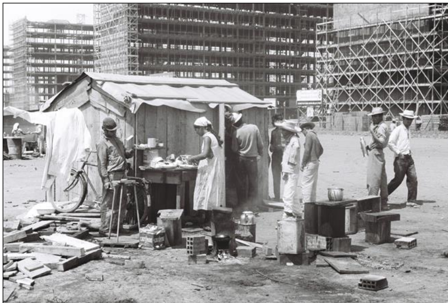
Figura 2. A construção de Brasília, de 1958 a 1960, acervo fotográfico do GDF.
