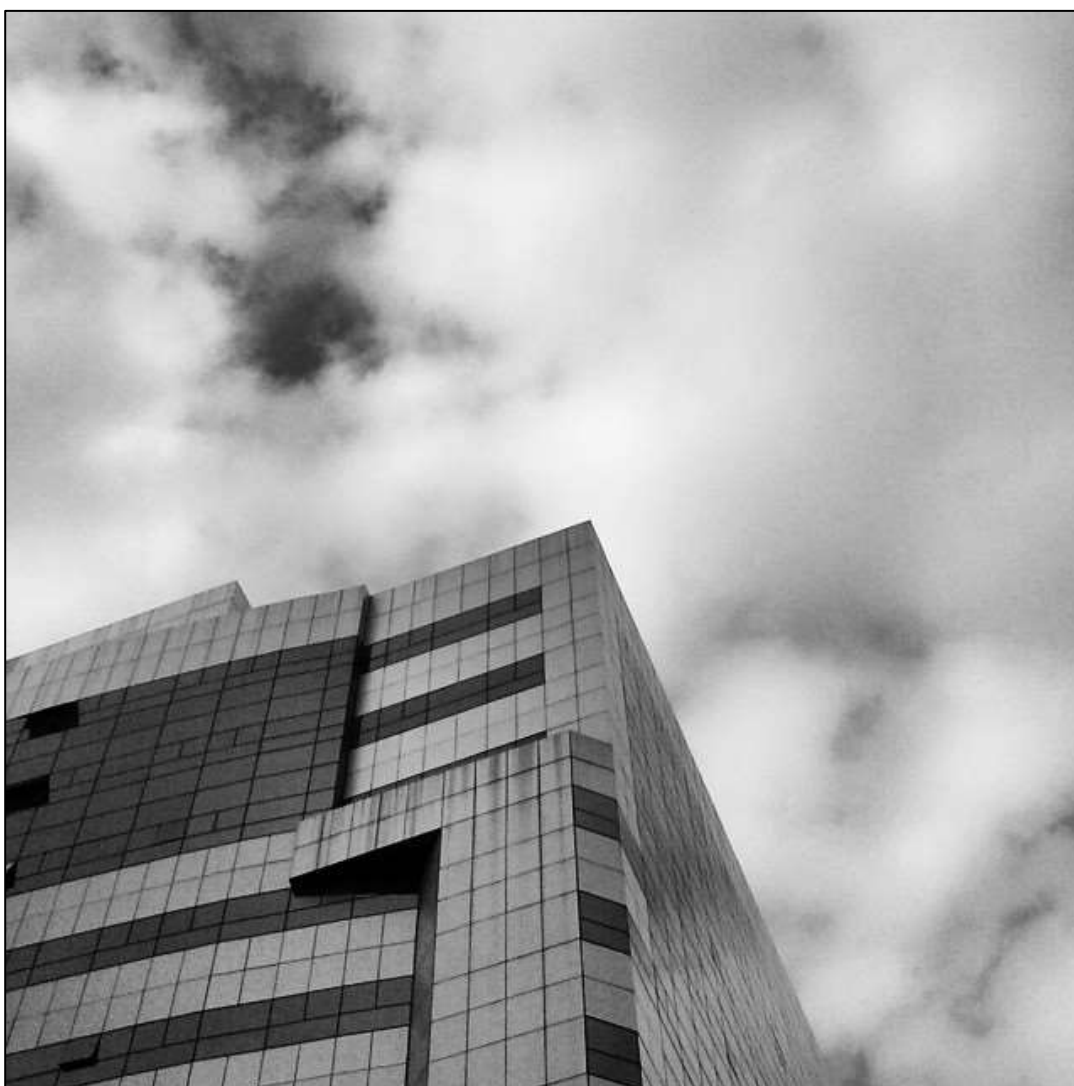
Figura 7. Detalhe do Fórum de Niterói.
