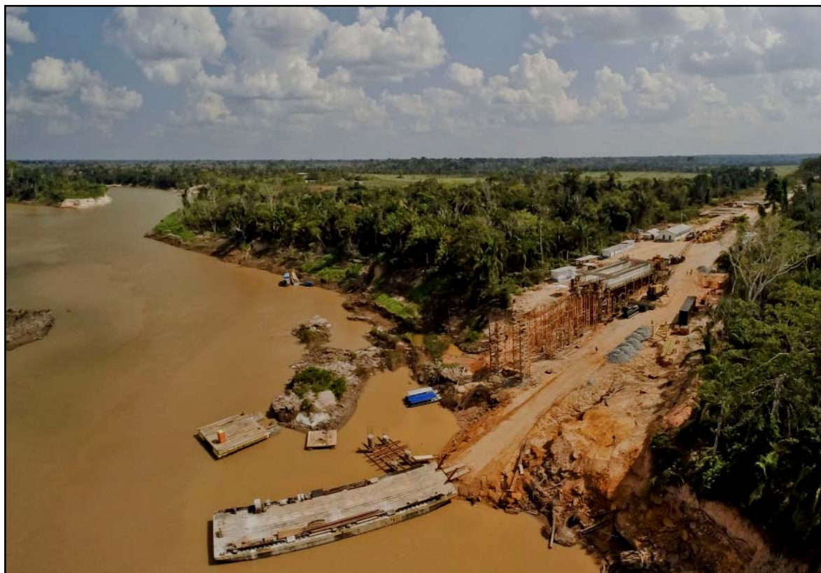
Figura8 - Canteiro de obras da ponte sobre Rio Madeira, na BR-364, Abunã-RO
