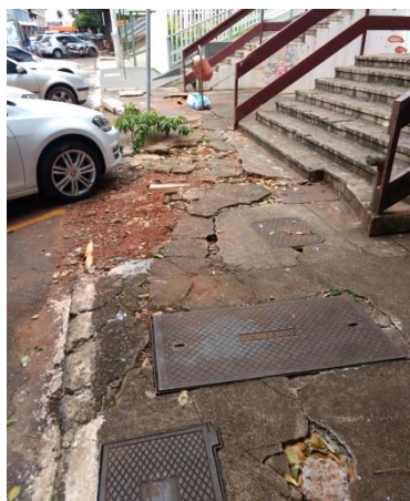
Figura 52: Barreiras do Setor Comercial Sul (Fonte: Própria)
