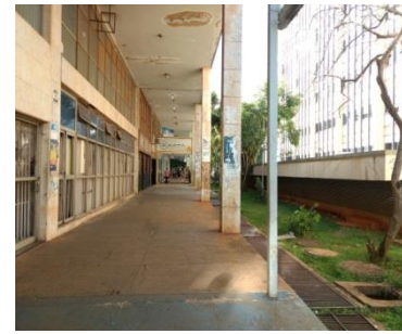
Figura 56: Muros de arrimo no Setor Comercial Sul (Fonte: Própria)
