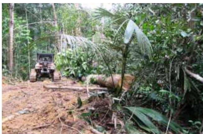
Figura 9 - Guinchamento de tora utilizando trator de esteira D6
