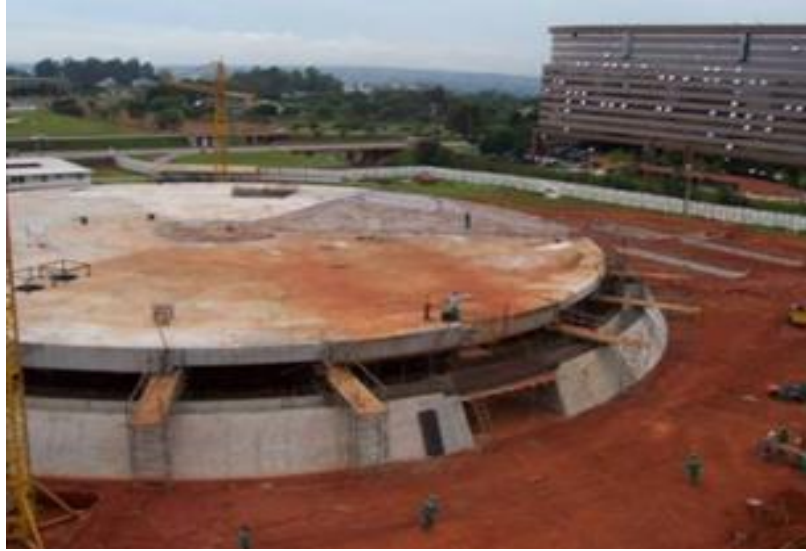
Figura 77 - Laje do pavimento de exposições concretada. Fonte: Via Engenharia.
