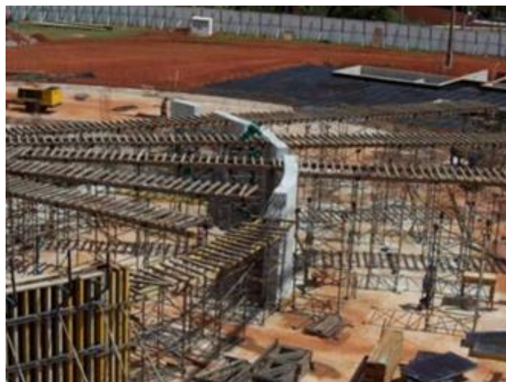
Figura 70 - Escoramento das vigas radiais 1. Fonte: Via Engenharia.
