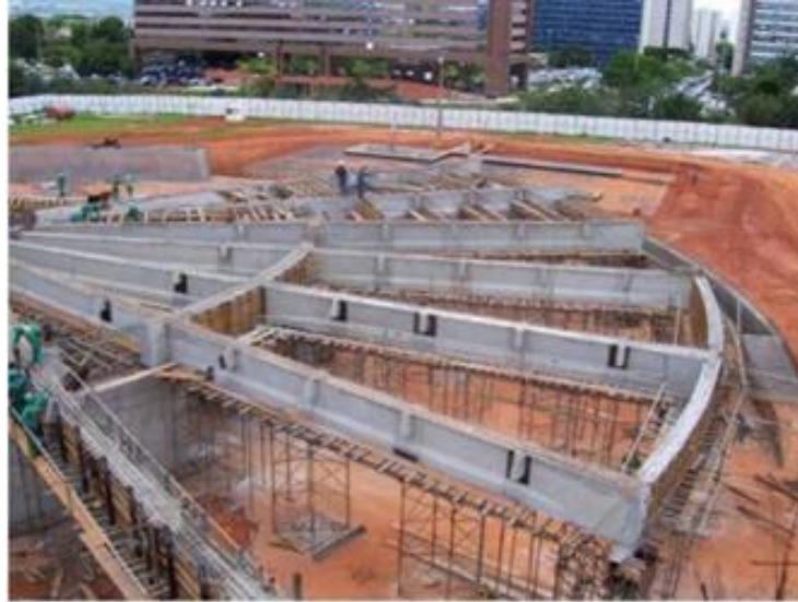
Figura 71 - Escoramento das vigas radiais 2. Fonte: Via Engenharia.
