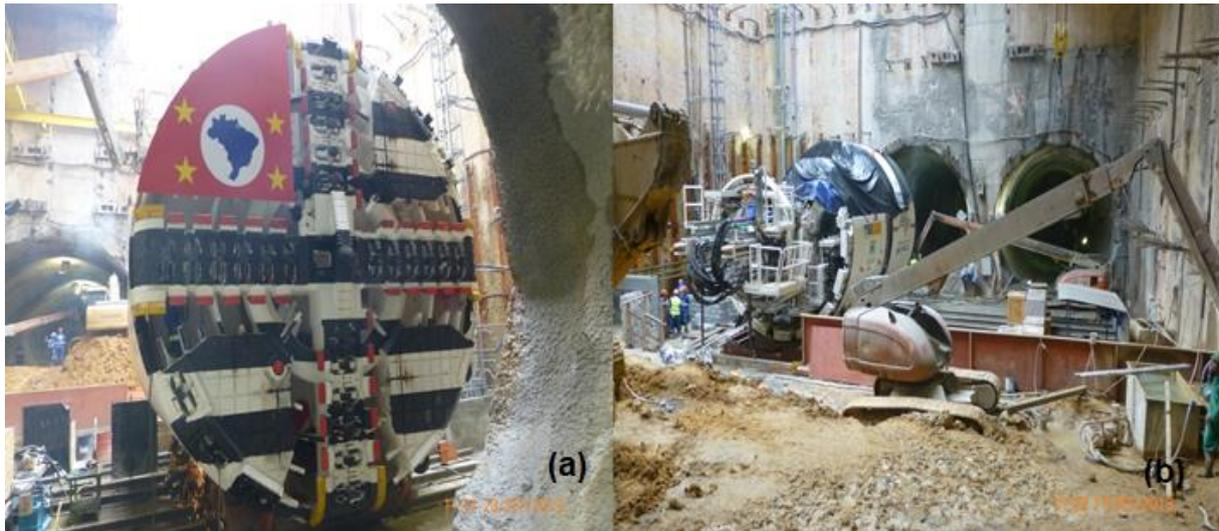
Figura 7.3 – Registros fotográficos da obra (a) Cabeça de corte da TBM Tarsila (b) Emboque das duas vias (Geodata, 2013).
