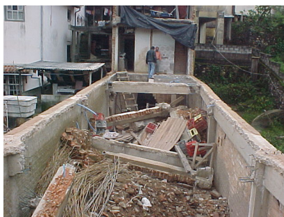
FIGURA 20 – Demolição do imóvel Fonte: ETOP
