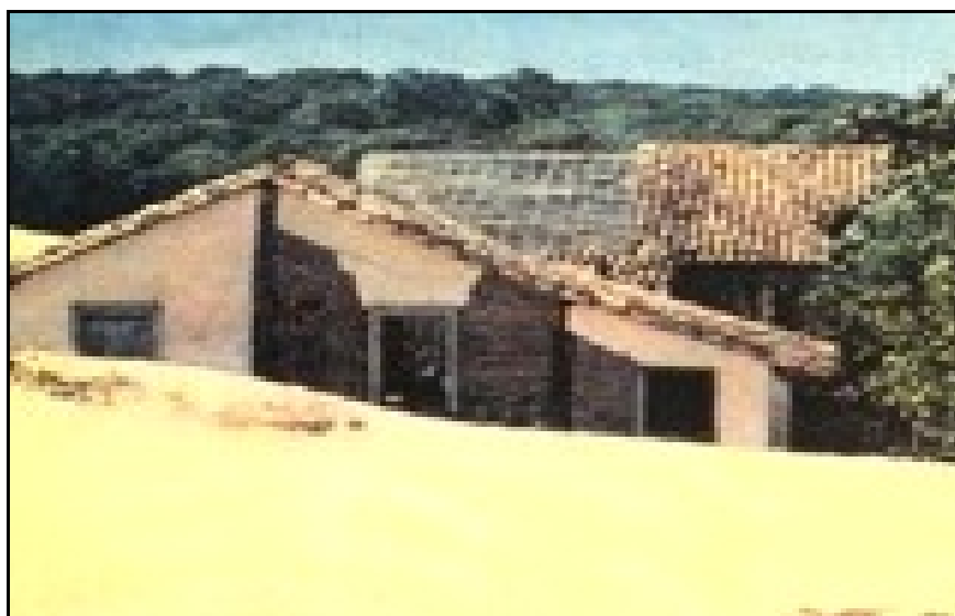
Figura 19 - casa da antiga Vila de Itaúnas sendo soterrada pela areia.
