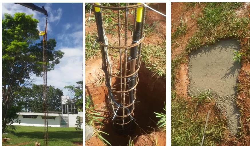
Figura 3.30 – Colocação da armação instrumentada no furo e concretagem da estaca junto com bloco de coroamento.
