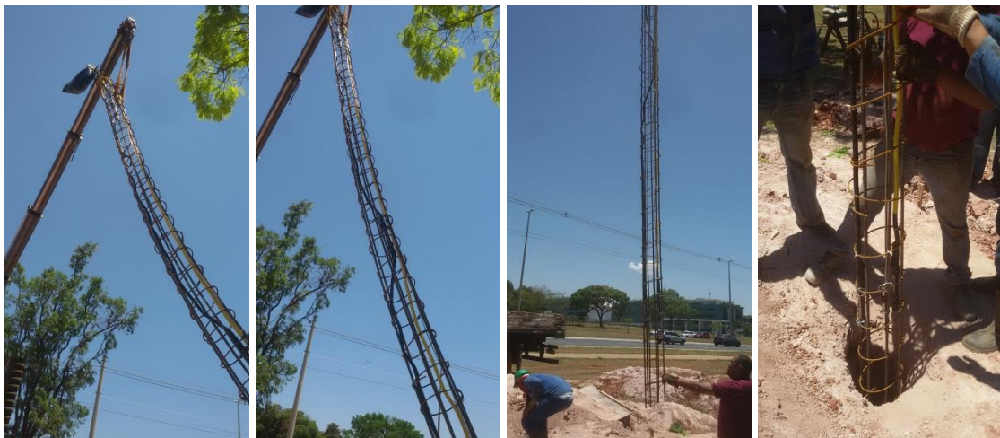
Figura 3.25 – Colocação da armação de ferro instrumentada no furo.
