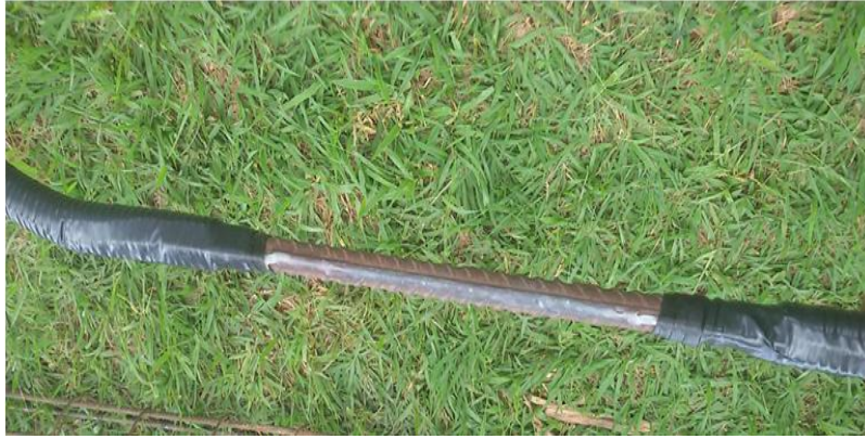
Figura 3.27 – Fibra ótica de leitura de deformação colada diretamente na barra de aço.
