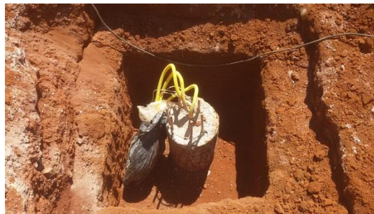
Figura 3.21 (b) – Escavação da cava para o bloco de coroamento.
