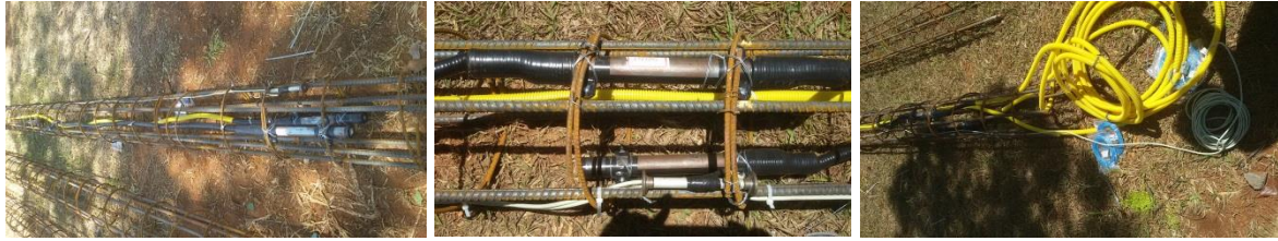
Figura 3.24 – Sensores óticos e resistivos elétricos instalados na armação de ferro.
