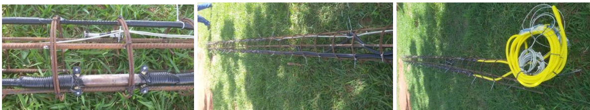
Figura 3.28 – Sensores óticos e resistivos elétricos instalados na armação de ferro.
