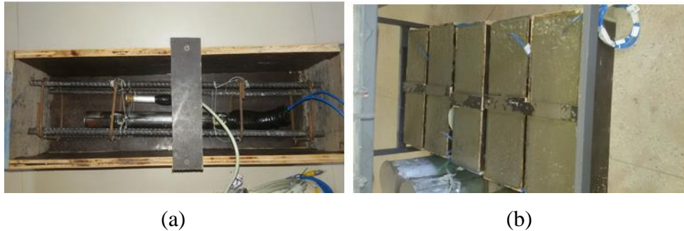
Figura 3.11 - (a) Colocação da armação instrumentada na forma; (b) – Concretagem dos pilaretes.
