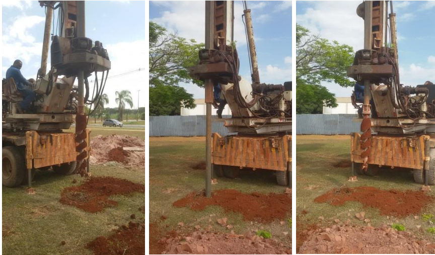
Figura 3.21(a) – Execução das estacas com trado mecanizado.
