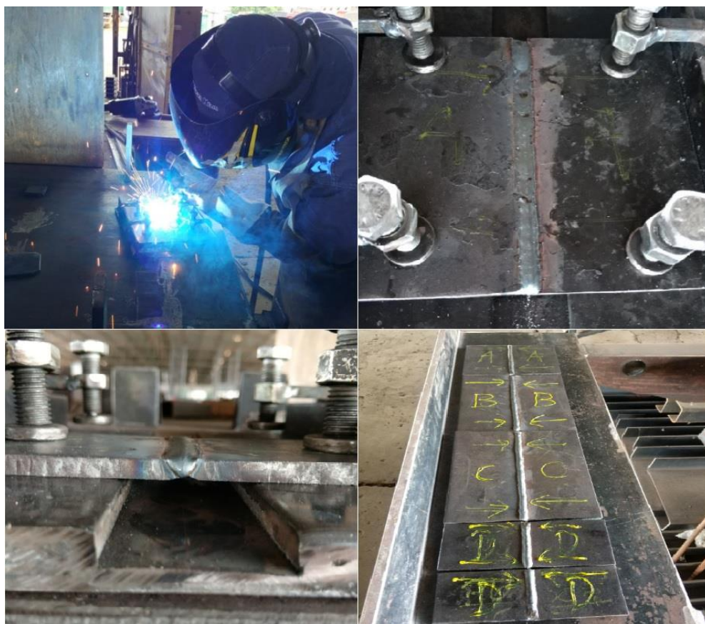
Figura 23. Processo de soldagem das amostras.
